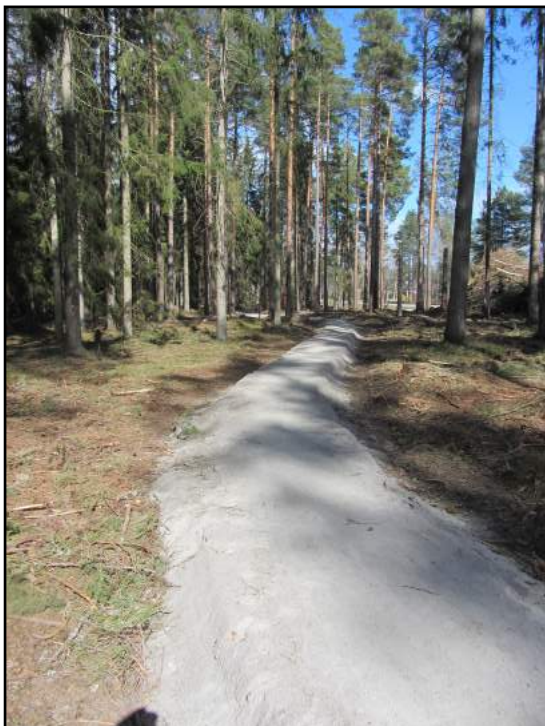
Nya skogsstigen, 30 cm hårdpackat stenmjöl ca 1 m bred slingrar sig genom skogen vid Lövskogsvägen.
