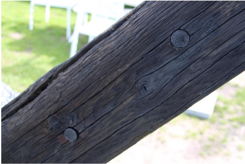
Dymlingar som sammanfogar stockens två delar, idag kompletterade med tre bultar
