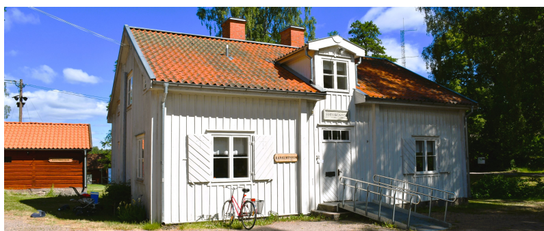
Slusskontoret vid Kanalmuseet, Skantzén, Hallstahammar.
