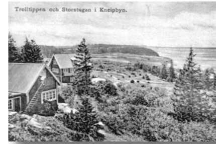
Villa Trolltippen" (dr Kallenbergs bostad) och Storstugan" (Restaurangen). Detta var den första bebyggelsen på området.
