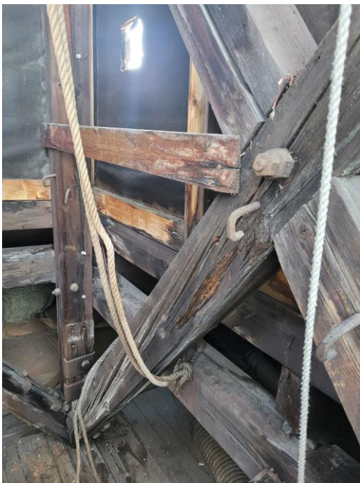
Till vänster: I tornets stomme fanns röta. (Foto 23.06.07 av Magnus Degerstedt)
