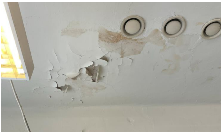
Nedanför: Taket läckte igenom. Fönstren hade röta i karmar och båggar. (23.05.25)
