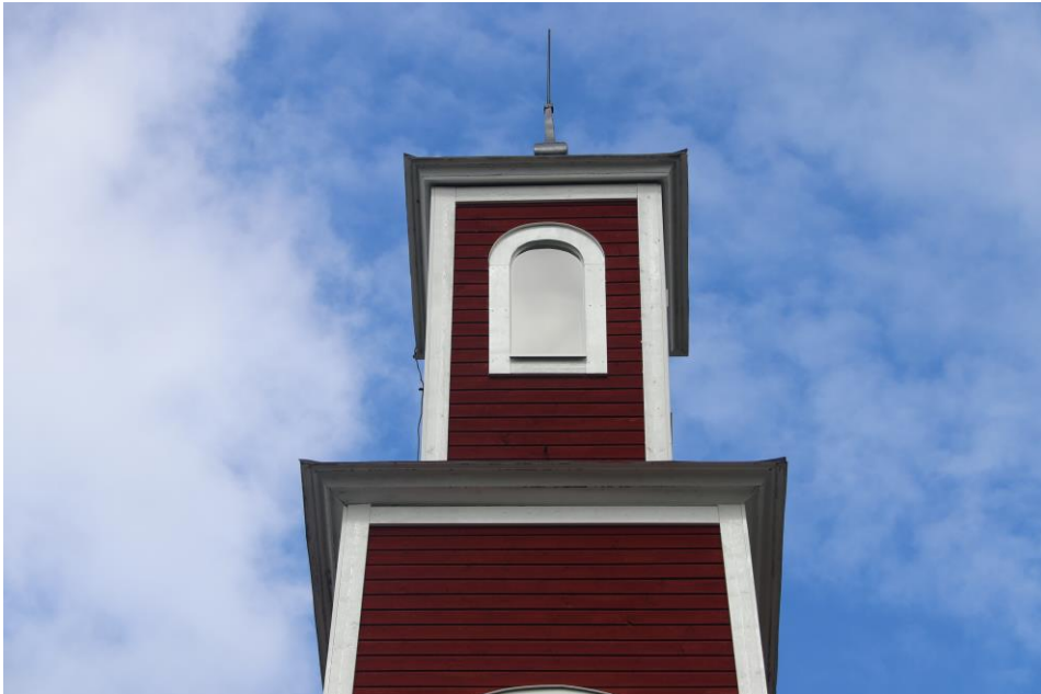
Den nya springan är ca 25 mm bred och ligger precis under takfoten på båda takutsprången. (23.08.14)
