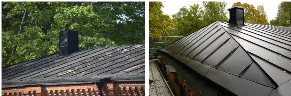
Ventilationshuvnen före till vänster (23.05.25) och efter till höger (23.09.21).
