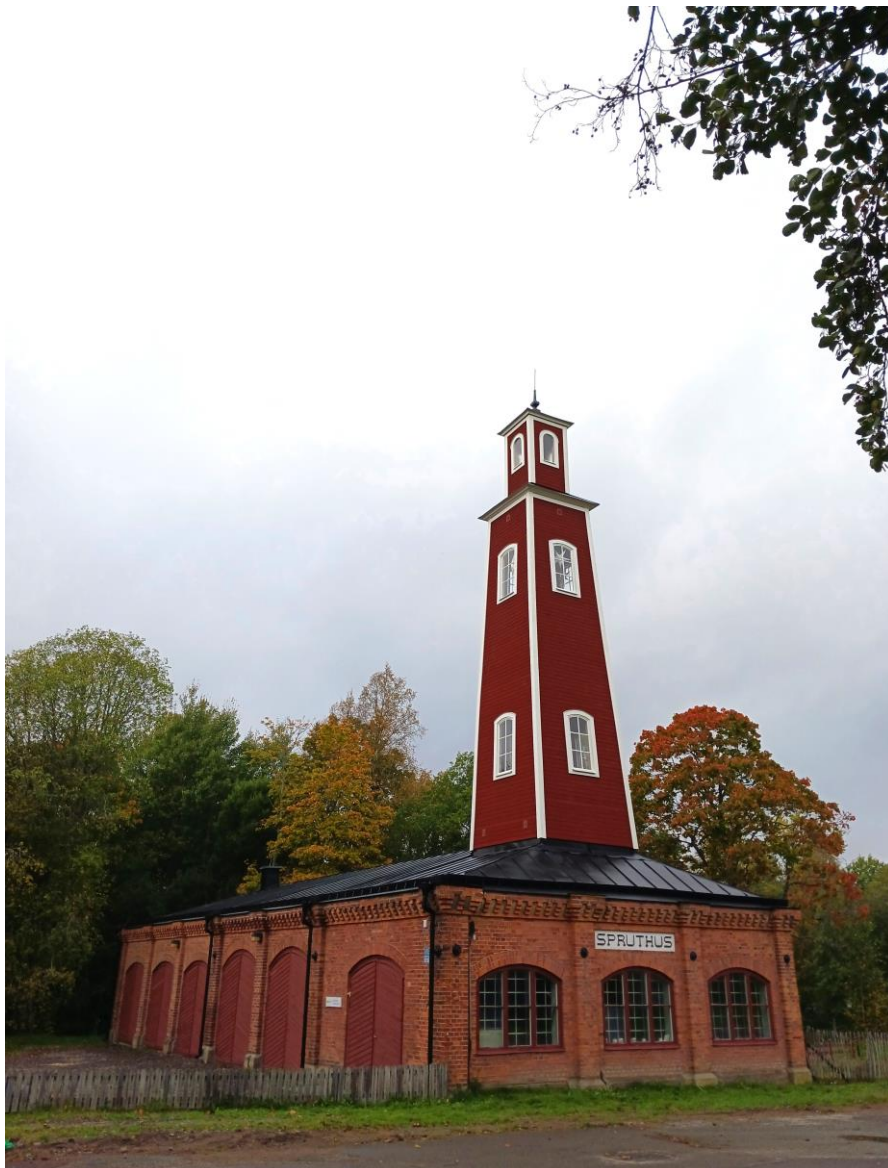
Ett nyrenoverat spruthus efter att byggnadsställningarna tagits bort. (23.09.27)
