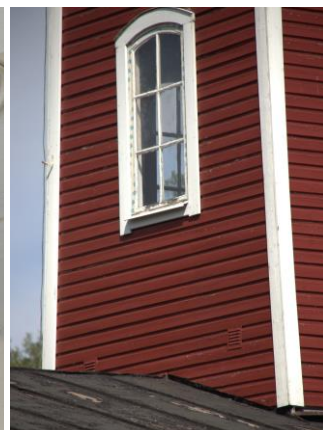
Nedanför: Taket läckte igenom. Fönstren hade röta i karmar och båggar. (23.05.25)
