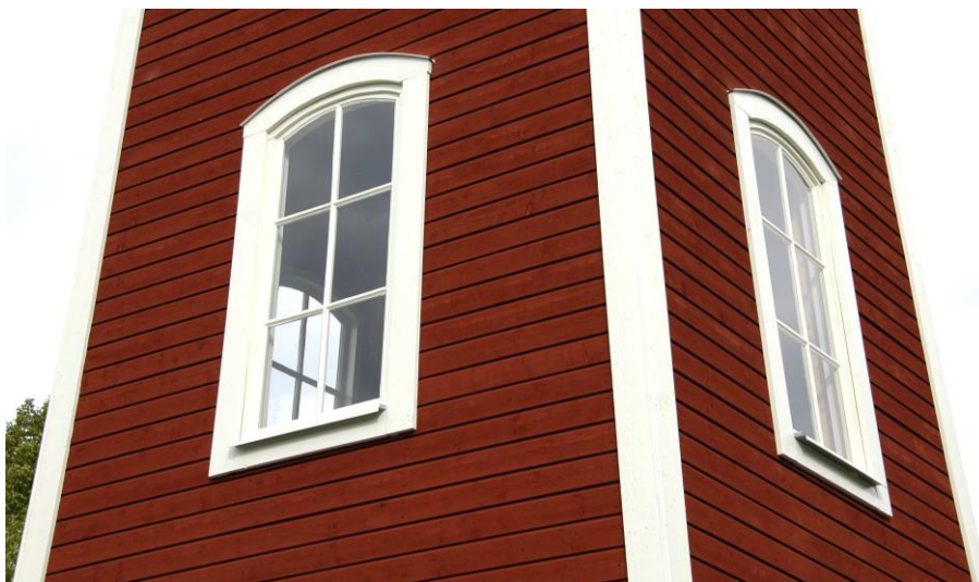
Plåtbeslag i överkant och nederkant av fönstren. (23.09.21)
