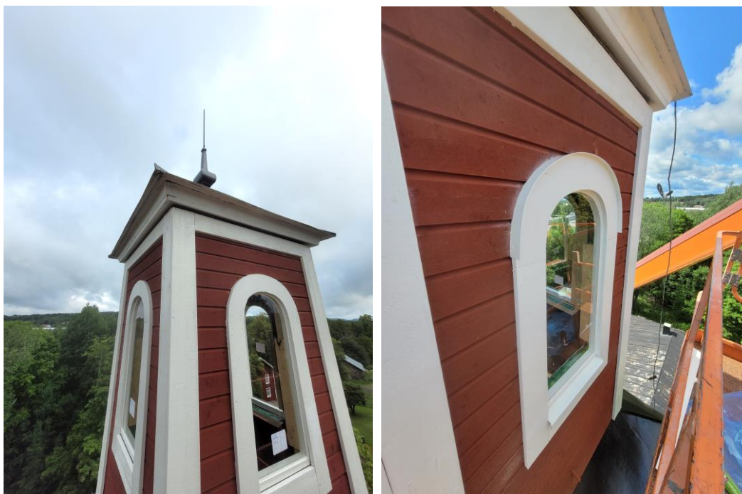
Nya fönster är monterade i de tidigare öppna gluggarna i klocktornet. En båge med glas döljs bakom fodret för att inte minska öppningen. (Foto: Magnus Degerstedt 23.07.07)
