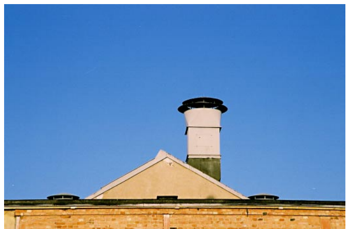
Ventilationshuv på industrihall från 1951 för varmpressning och bearbetning av mässing.
