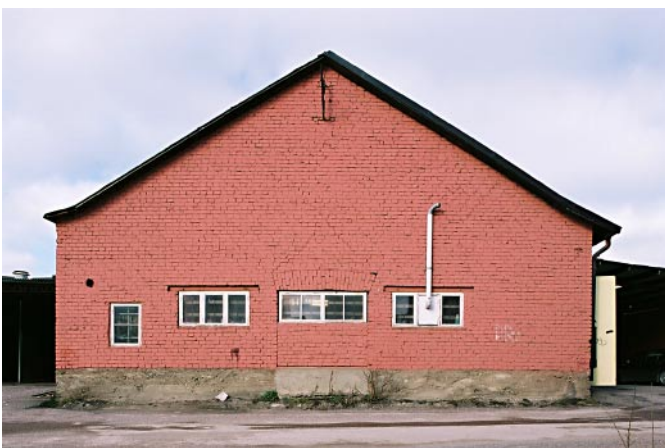
Tegelbyggnad från 1916-17, okänd användning.
