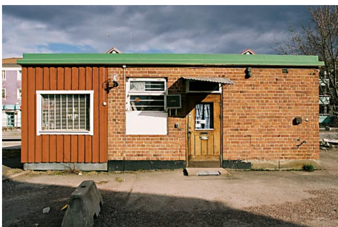
Vaktstuga vid Optimusvägen från 1948, ombyggd för senare verksamheter.
