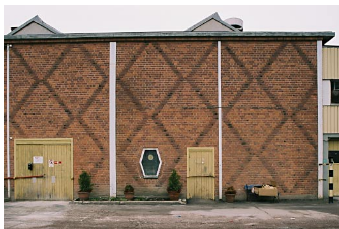
Detalj av mönstermurning på fasaden mot Optimusvägen.
