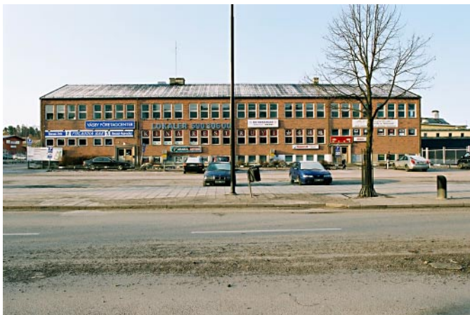
Kontorsbyggnaden mot Centralvägen från 1948 med omklädningsrum, matsal, kök m. m.
