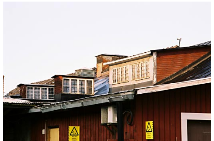
Lanterniner på en av de äldsta byggnaderna, ursprungligen för glödning av rörämnena.
