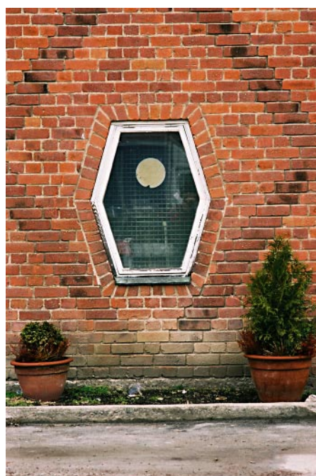
Tidstypiskt fönster på fasaden mot Optimusvägen på industrihallen från 1948.
