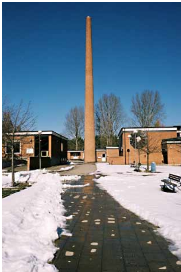
Panncentralen med sin magnifika skorsten.
