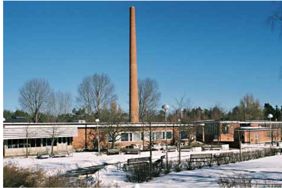
Matsals- och köksbyggnaden från sydväst med panncentral och simhall till höger.
