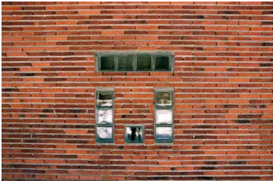
Aulans västfasad, detalj - tidstypiskt användning av glasbetong.
