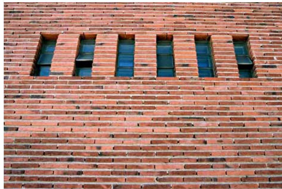
Matsals- och köksbyggnaden: detalj östfasaden, ventilation till kök?
