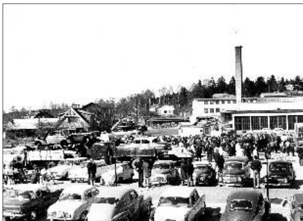
En riktig röjardag. På baksidan av detta foto står det ”Operation Renat”. Foto: Lennart Hedlund
