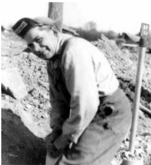
Harry "Ärtan" Sandberg under grävning av kabelgrav mellan elverket och Marabou.
