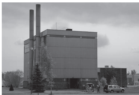
En av Ranstadsverkets kvarvarande byggnader som kommer att rivras. Häggums hembygdsförening arbetar med att dokumentera och intervjua de som arbetade med uranhanteringen
