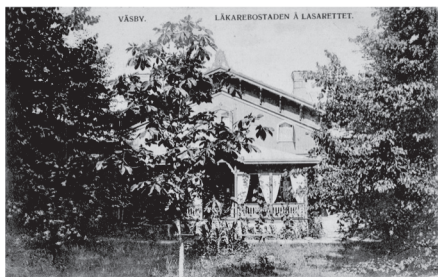
Läkarbostaden å lasarettet
