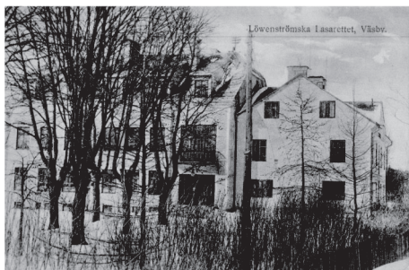
Den nya huvudbyggnaden med gamla sjukhusets gavel t.h.
