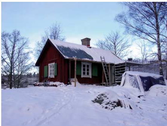
Bild 2. I november och december genomfördes takomläggningen ofta i uppehållet mellan blåst, regn eller snö. Foto Hans Bärning
