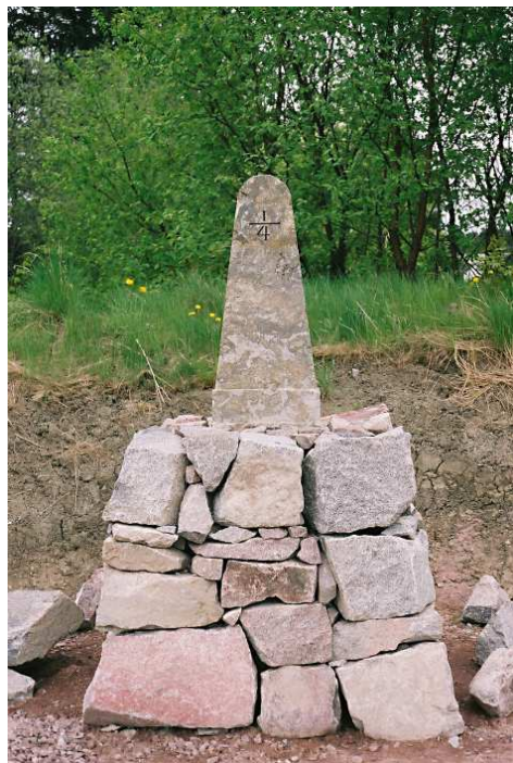
Milstolpen har vid återuppförandet fått ett kallmurat fundament av ursprunglig storlek.
