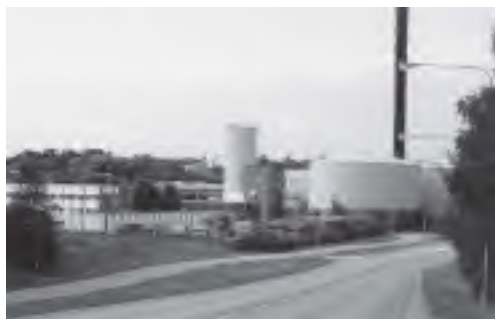
Väsby Värmeverk. Foto: Allan Andersson
