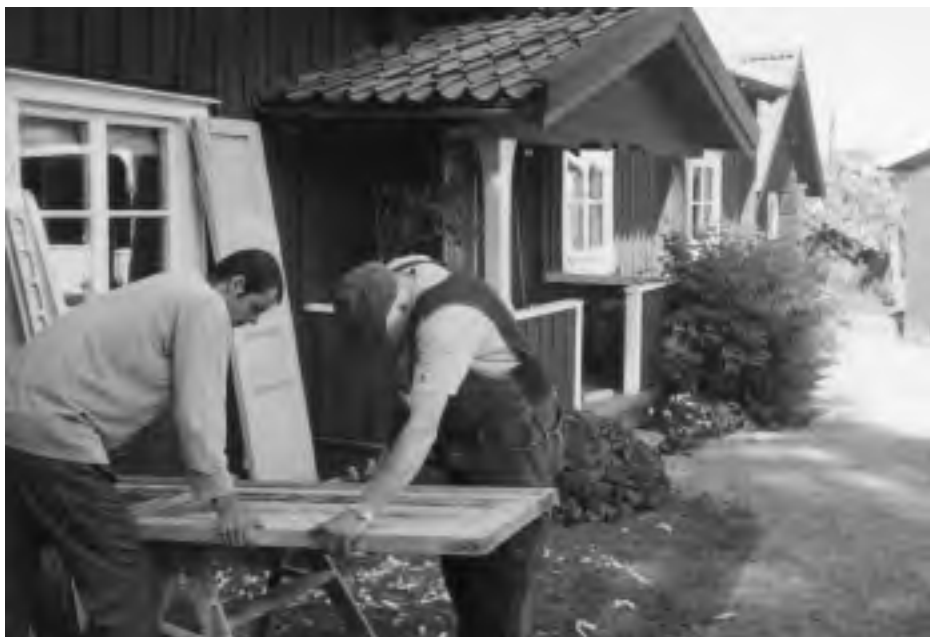
Renovering av prästgårdsflygeln på gammalt sätt och med gamla metoder. Här förminskas de gamla spegeldörrarna som ska sitta innanför ytterdörrarna.
