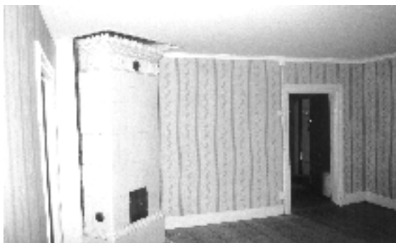
Rummet iordningställt med nytt undertak.
