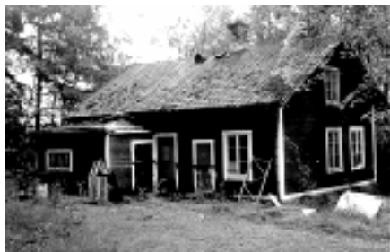
1873 - 1950-talet Strömsbergs småskola på åsen nära Hammarby Apotek undervisade i nära 80 år
