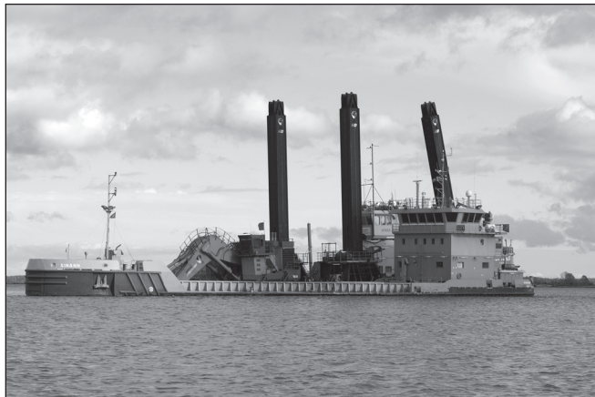
Främst syns en av pråmarna som är tungt nedlastad utanför Kälsholmen. Bakom gräver en stor grävska upp det som ska muddras och som den stjälper i fartyget. Pråmen tömmer sedan massorna vid Medholmen genom att öppna luckor i botten
