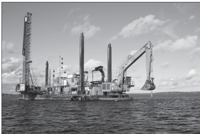
Ponton som förankrats i botten har grävare som tar upp ca 18 kubikmeter bottensediment i varje skopa
