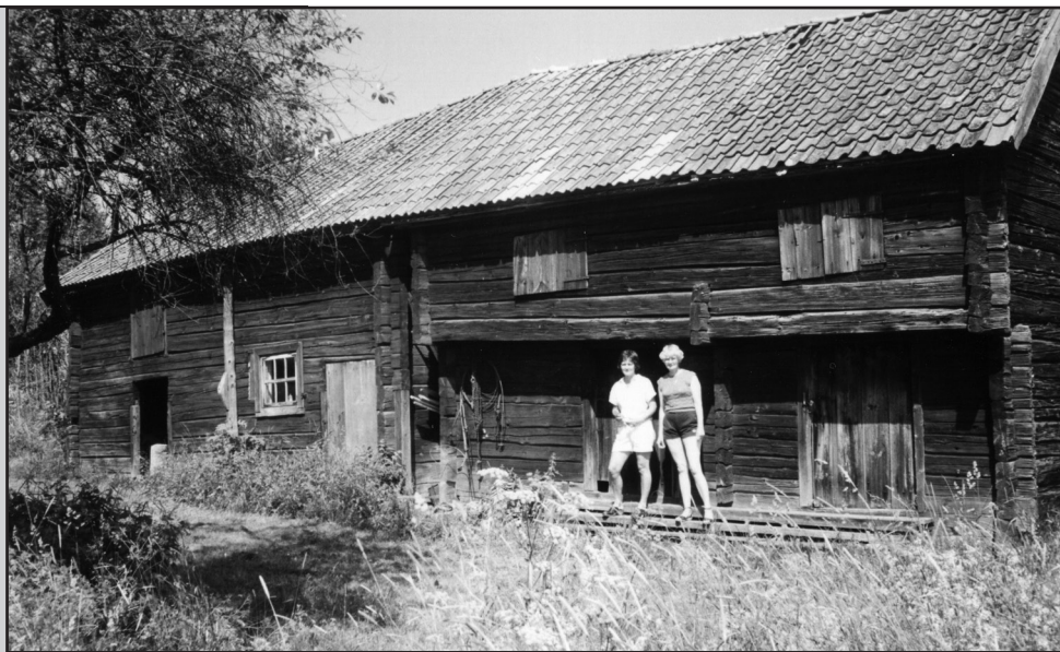
Loftboden är Tvärnös äldst bevarade byggnad från 1700-talet.
