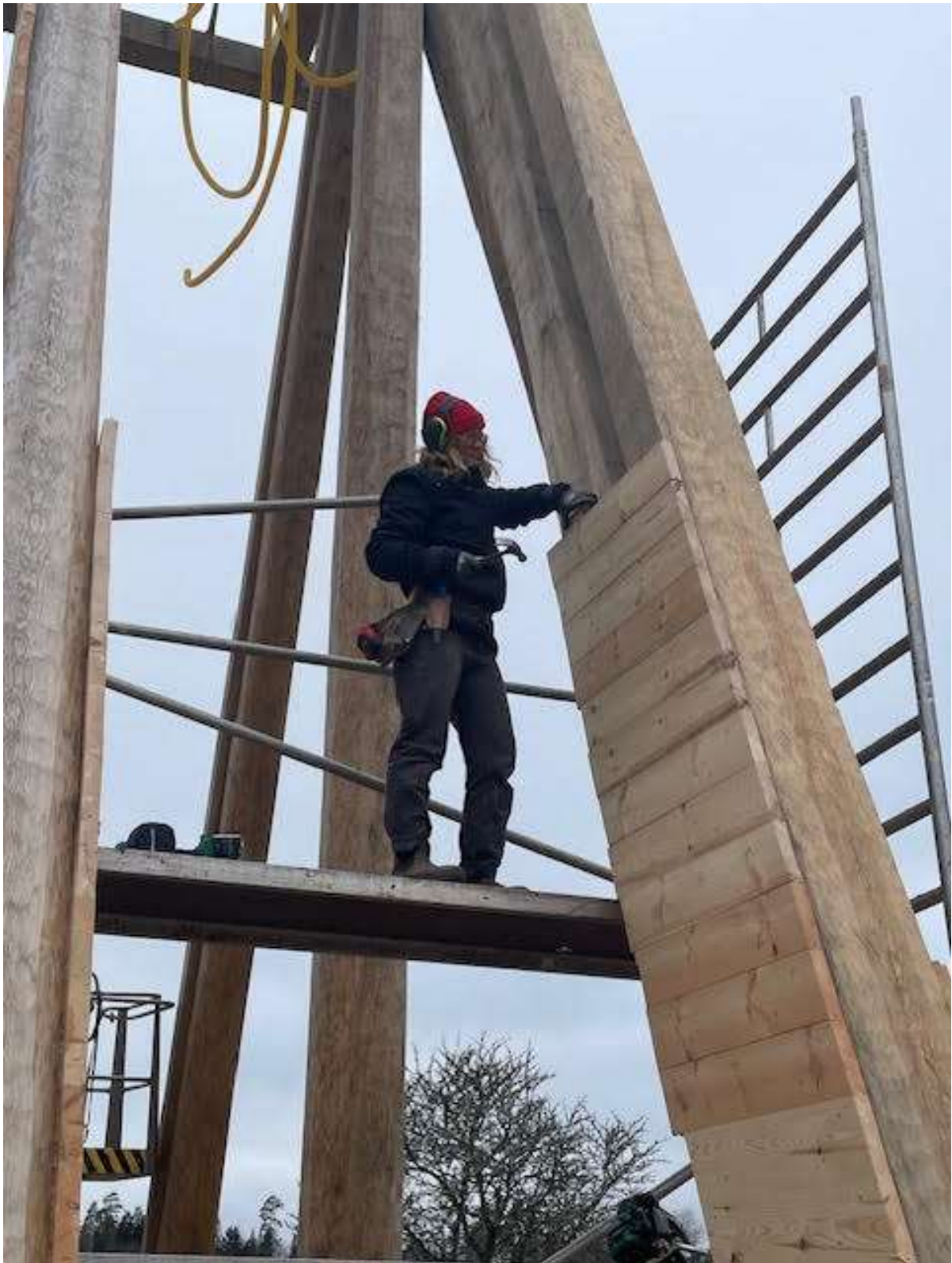
Bockbenen kläs in och förstärks med plank
