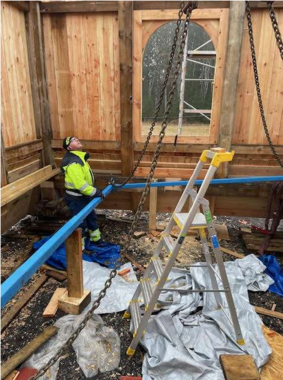
Förstärkning med lyftram inuti
