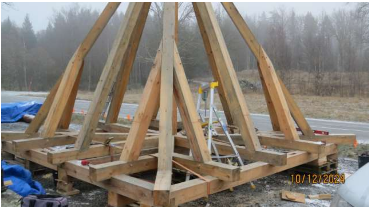
Stommen till taket klar, rejäla takstolar.....
