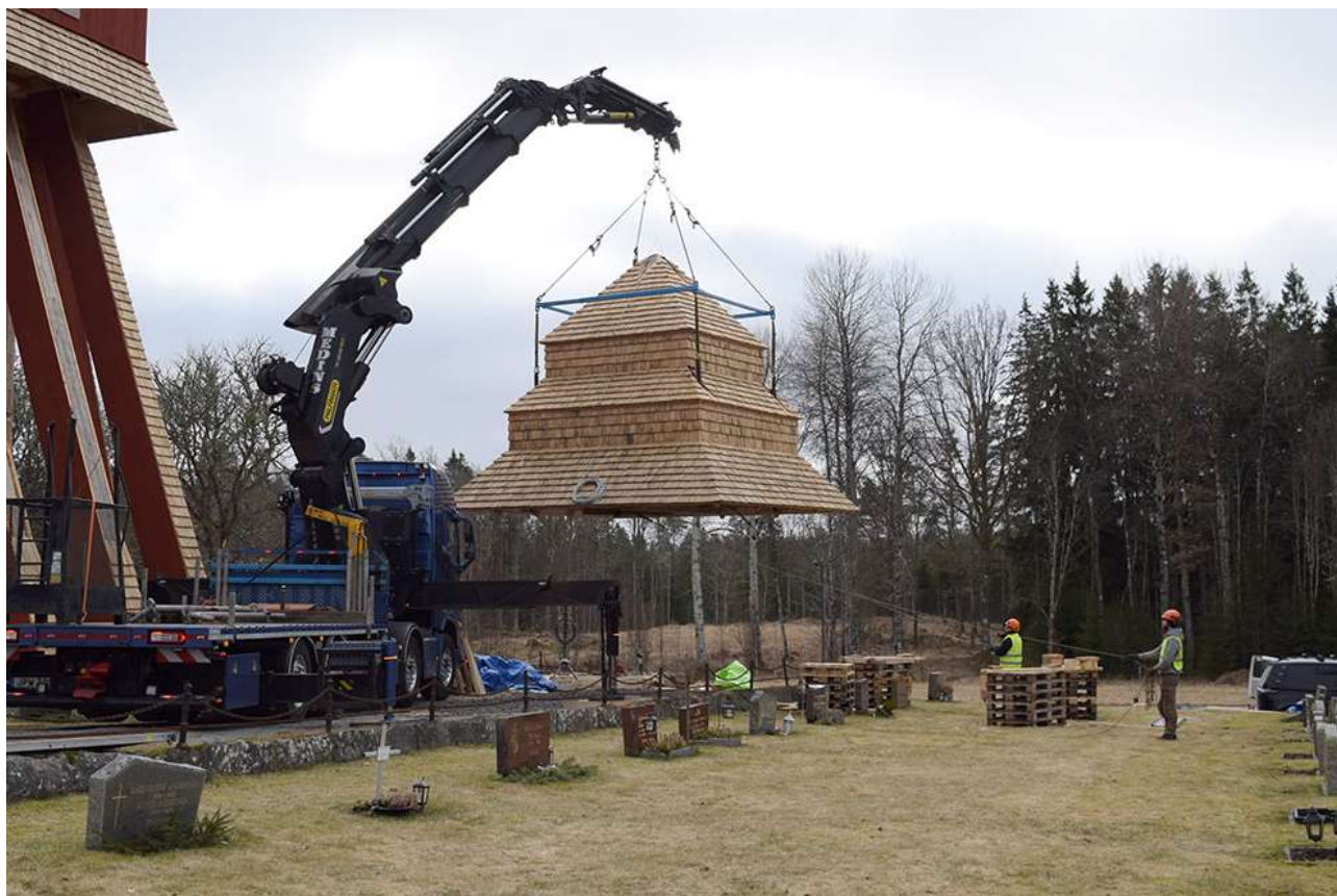
Takdelen var alltför tung och lyftet fick avbrytas
