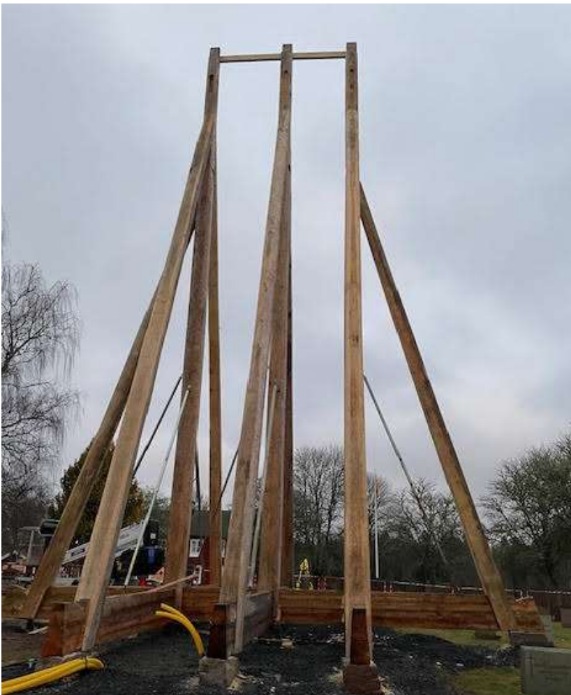
Januari 2025, stommen är rest, och om ca en månad är det dags att lyfta upp ljudlådan och taket på plats.
