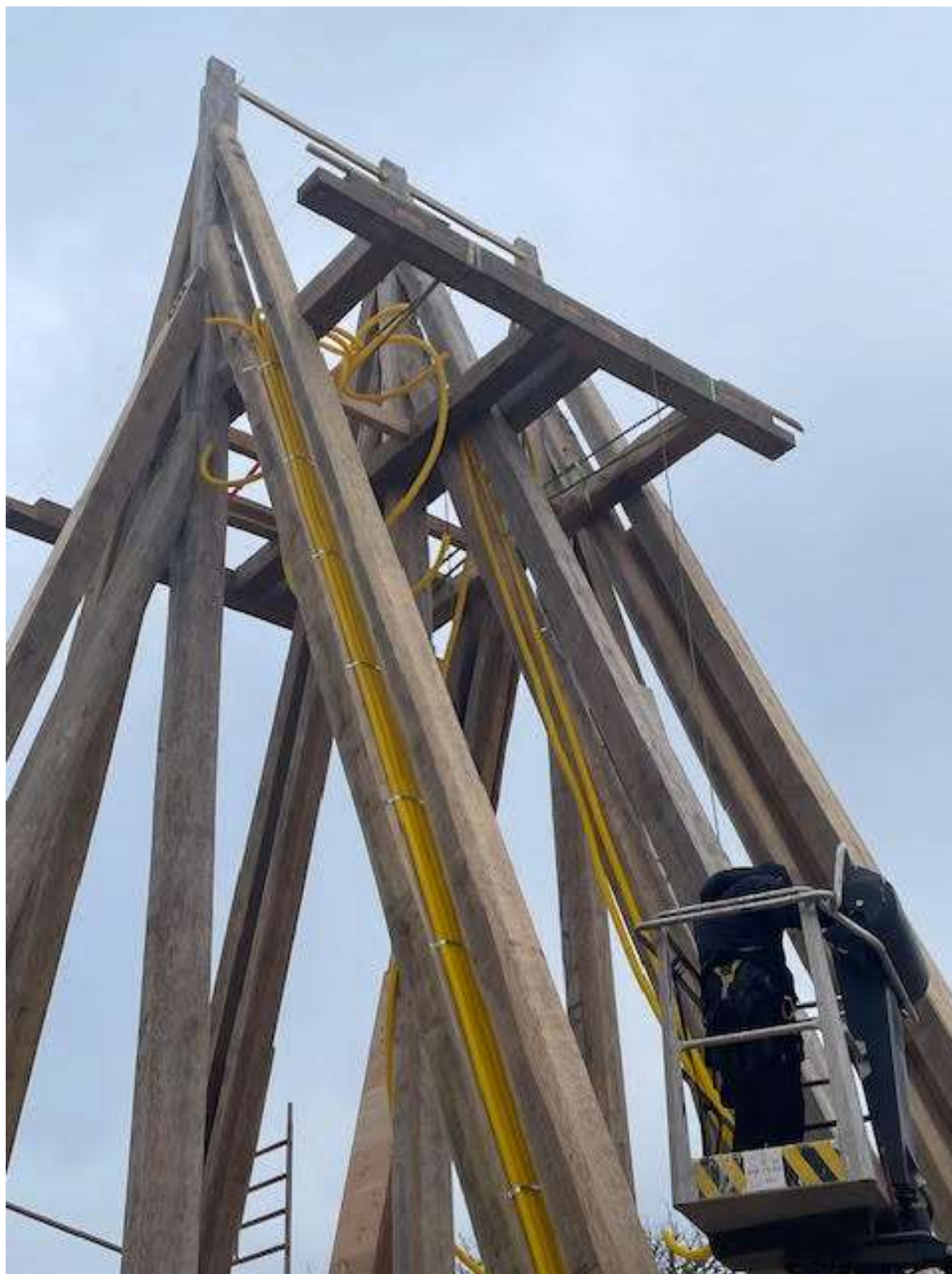
Kabelrör till klockornas ringanordningar, lucköppnare mm framdragna
