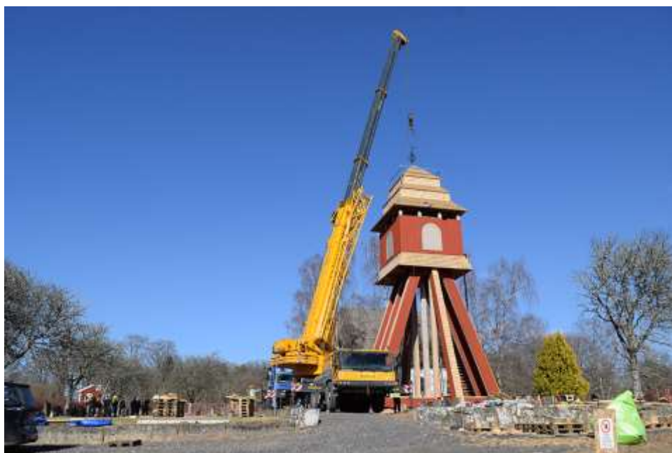
En ny och större kran på plats och ordningen återställd 😊
