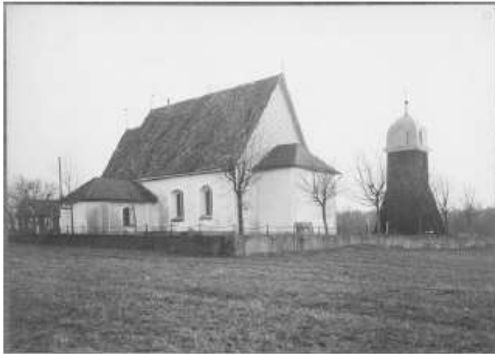
Kyrkan från nordväst där man ser att klockstapelns huv är plåtklädd. Foto: Dan Samuelsson 1923, RAA.
