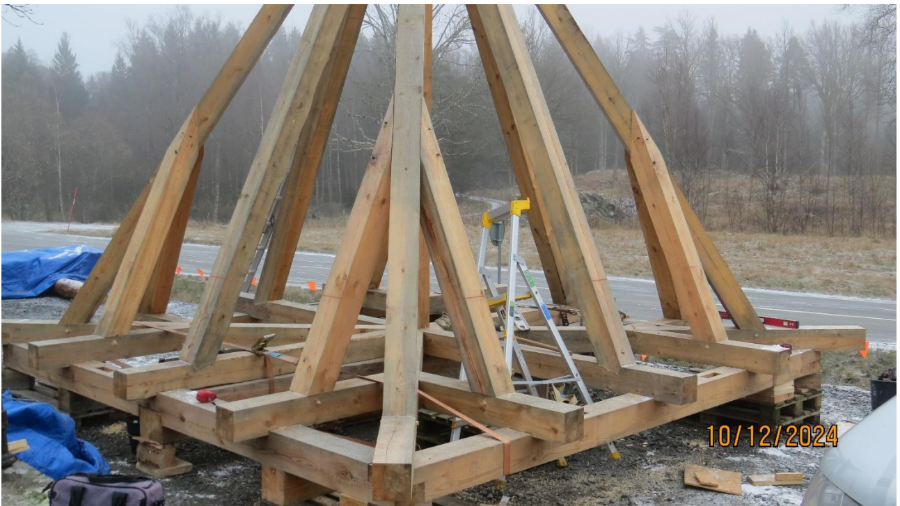
Stommen till taket klar, rejäla takstolar.....
