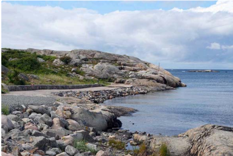
Under ombyggnad. Gångväg ut i betong på en bädd av spräng- och natursten.
