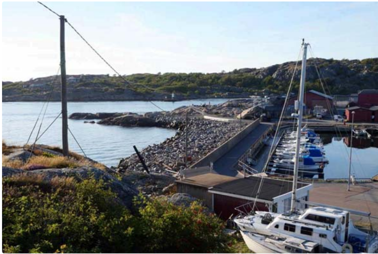
Vägen ut till Kläppholmarna går via den kombinerade vågbrytaren och vägbanken.
