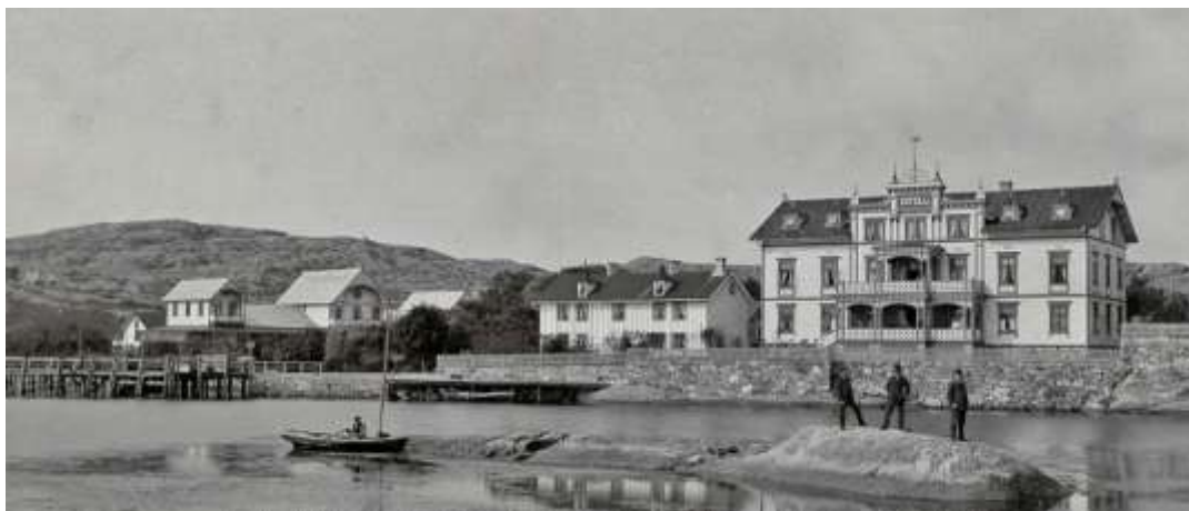
Bild 14 Styrso Hafsbad med Restauration byggt 1882 och Hotell byggt 1891
