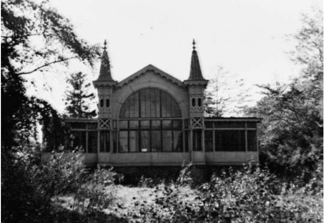
Bild 45 Dr Peter Silfverskiöld flyttade Mohriska Paviljongen till Styrso 1887. Huset revs 1958 för att ge plats till ett nytt ålderdomshem. Som revs för att ge plats till nuvarande Styrsohemmet.
