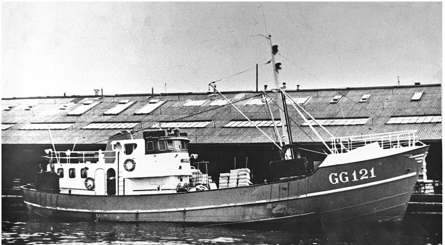
GG 121 Liberty 4 Byggd i Holland levererad 1960 Br.ton 119 L 23,40. m B 6,20 m. D 3,05 m. Motor Alphadisel 5 cyl. 360 hk
