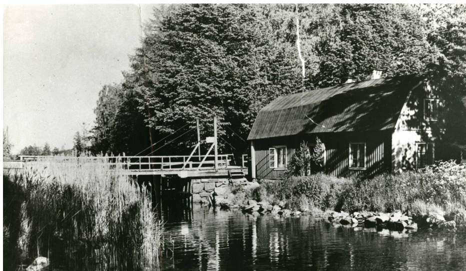
Strömme kanal och kanaltorp, 1920-tal. Bron öppnades vid denna tid som svängbro. Foto: okänd.
