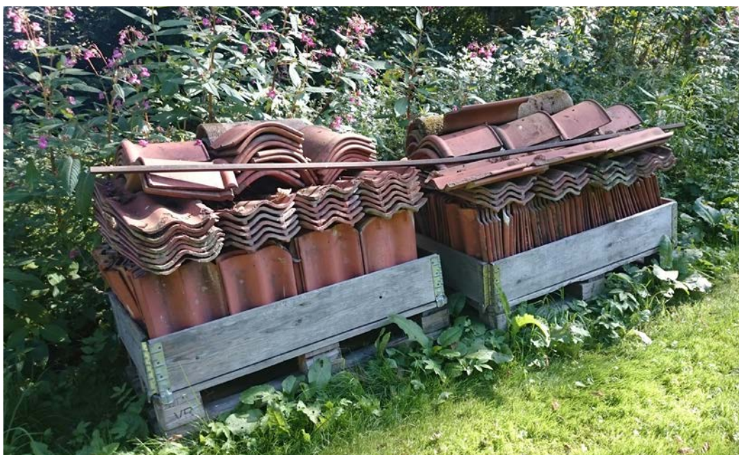
I väntan på byggnadsvårdande insats
