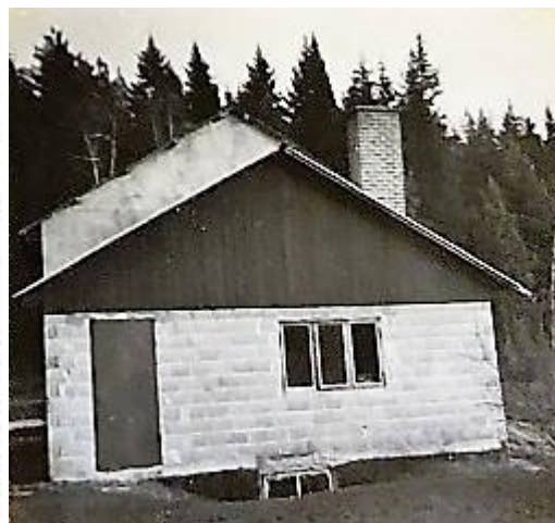
Byggnation av nya huset med värmecentral
