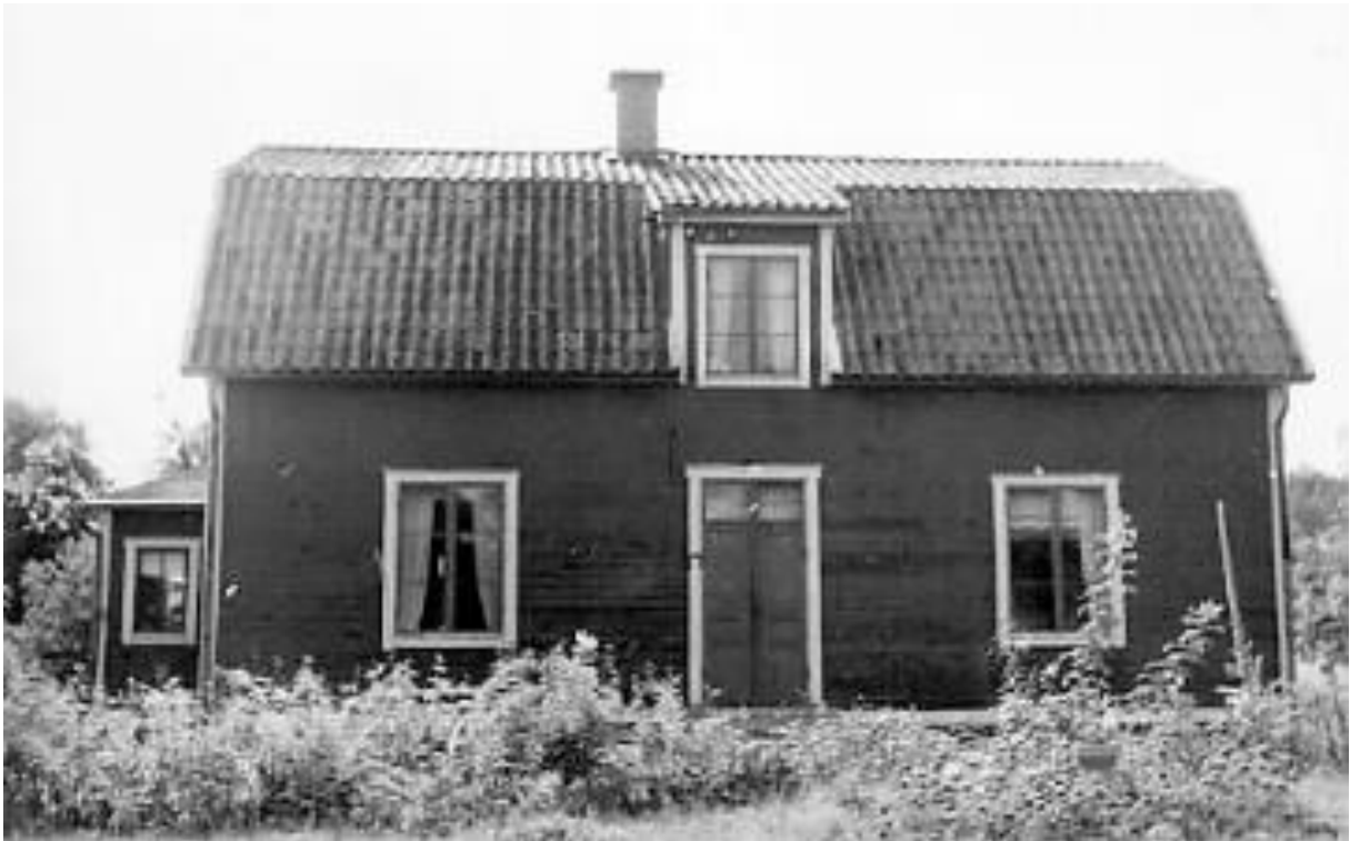
16. Skillra manbyggnad Skillra med manbyggnad uppförd 1924, Eckleseastiskt löneboställe. Foto Dan Samuelsson 1947
