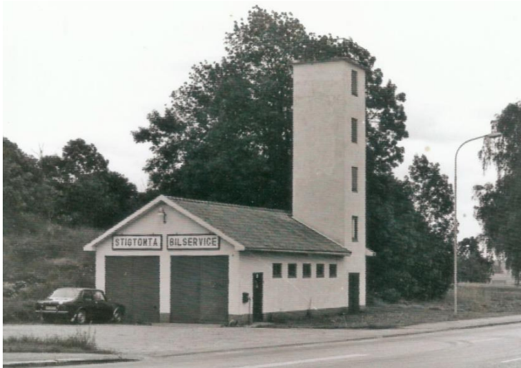
Brandstationen när den fungerade som bilverkstad.
