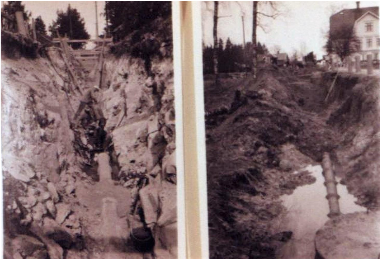
88 Vatten- och avloppsarbeten, Hallavägen – Bärbovägen
