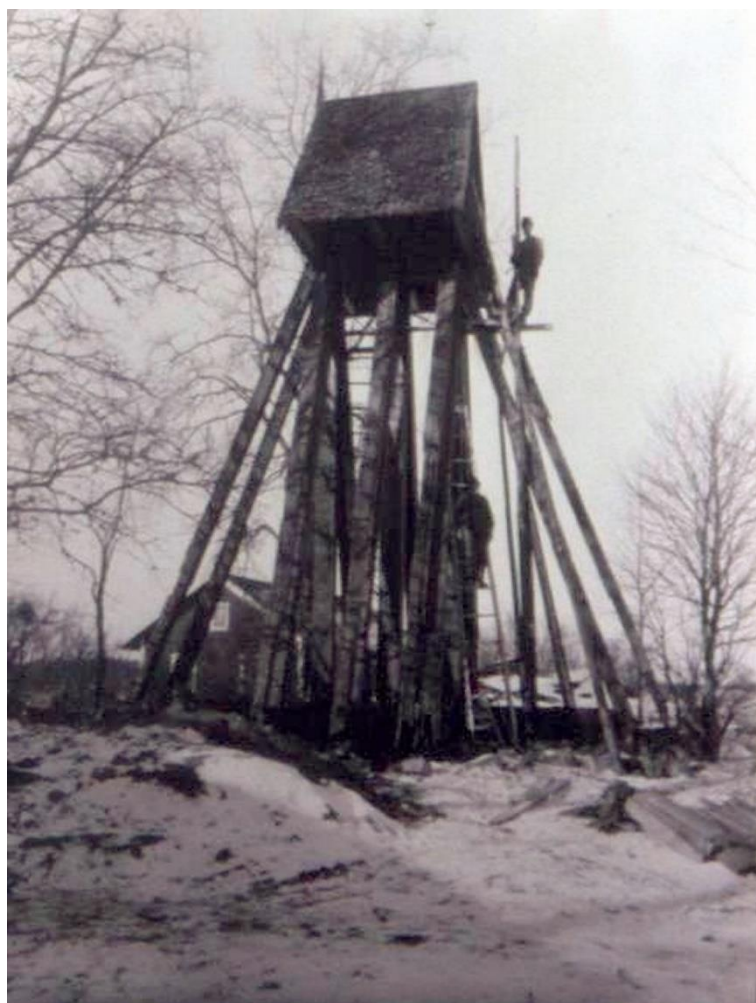
Bild 15 Nykyrka klockstapel under uppbyggnad
