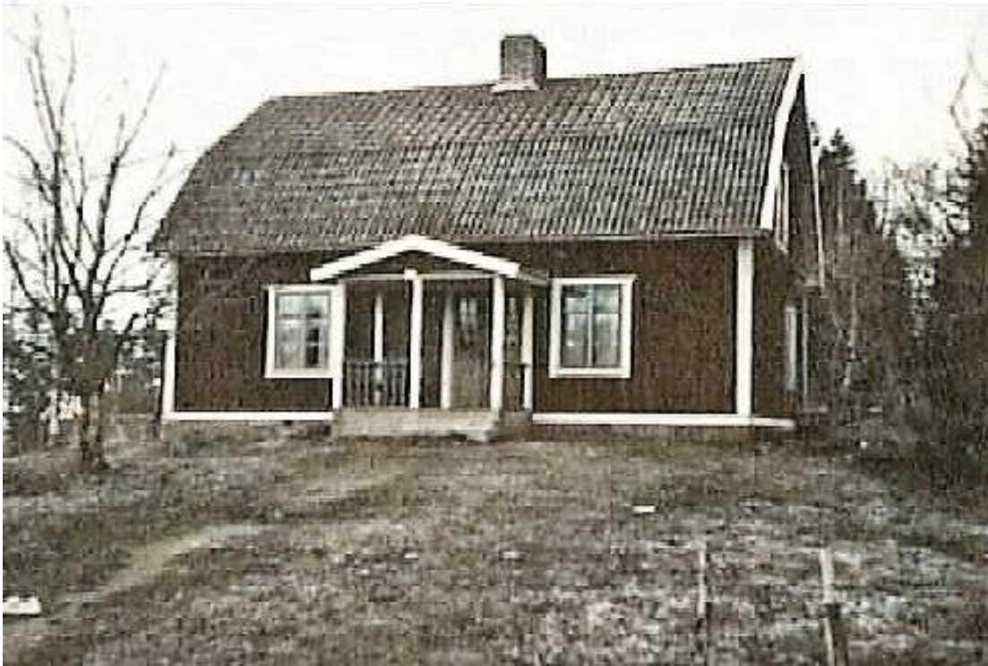
Gölstugan. Huset uppfört 1916. Foto 1947 Dan Samuelsson, Sörmlands museum
