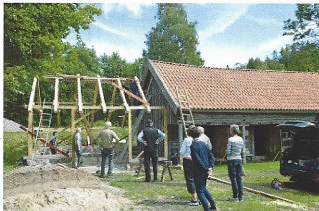
Takstolskalas i samband med nybyggnad av vagnbod vid hembygdsgården, 10 juli 2020
