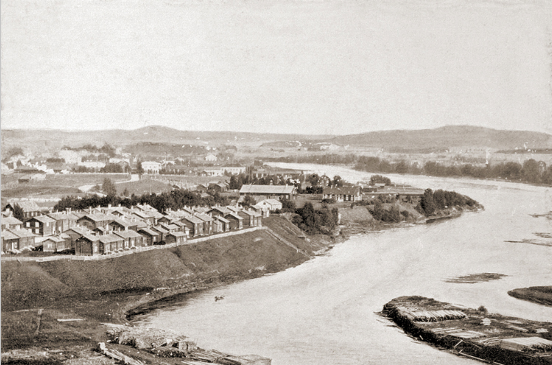
Fotograf: Jonas Nordstrand, 1897. Observera kyrkstugan på älvskanten. Fotografen verkade i Skellefteå mellan åren 1895 och 1907.
