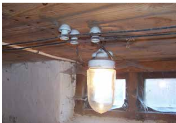
Eldragningar i Säflacka skola i Emmislövs socken, som det såg ut på 1920- och 1930-talen. Foto: Sven Jensén 2008
