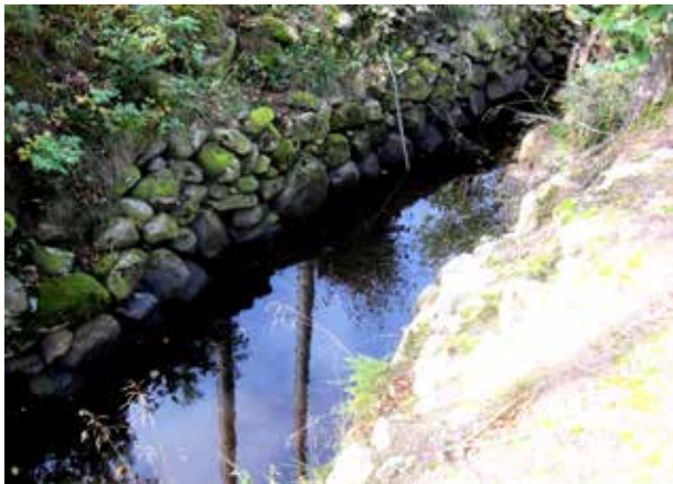
Bild 13. Vackert stensatt kant intill "Kvarnvången" i Broestorp. Meningen var, att den skulle ge vattnet en rejäl fart och driva ett elproducerande kraftverk. Den byggdes upp av Edvin Martinsson och hans far Matti. Den eleganta stensättningen kom aldrig till någon riktig nytta eftersom en elförening började leverera elström från Sibbhult 1925.
