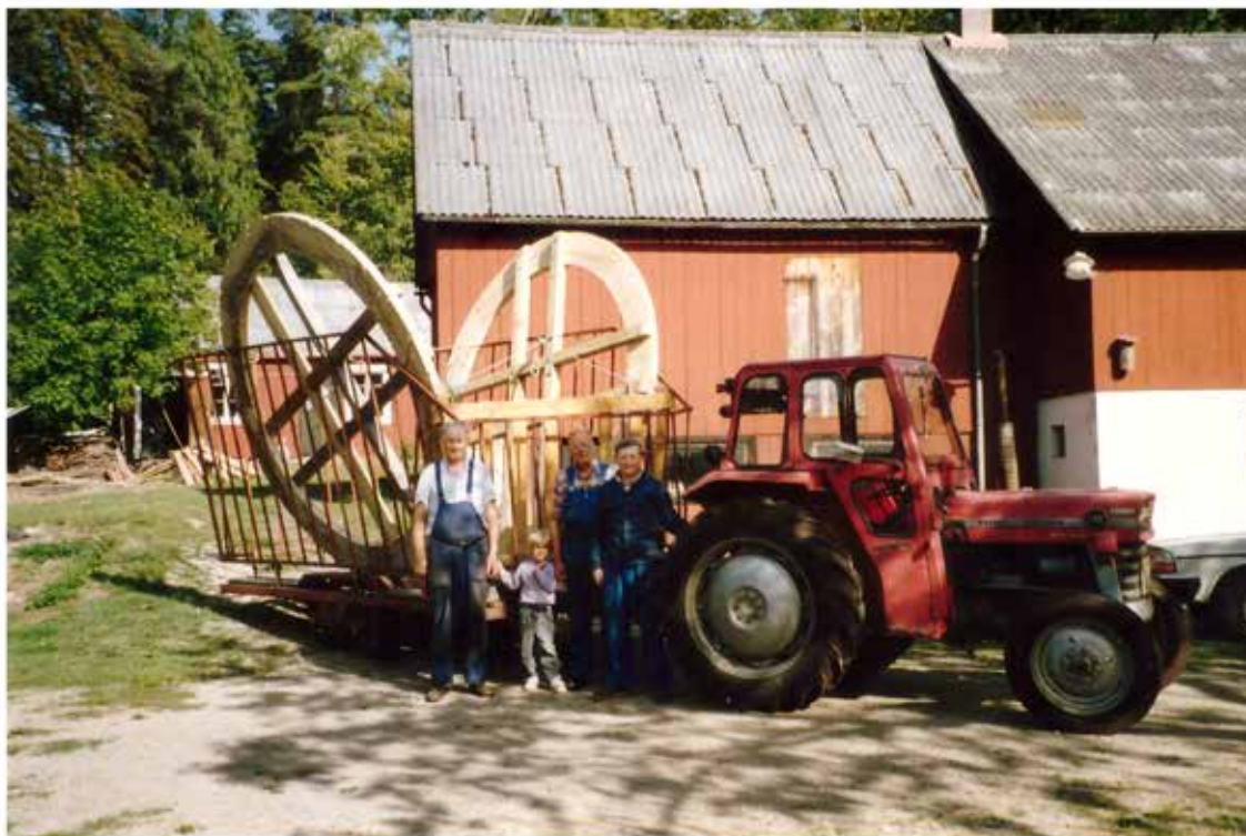
Hjulet gjordes av impregnerat furuvirke och axeln av ek. Vattenhjulets båda sidor transporterades från Björnvik till Skinnewmyra i en balvagn och sattes ihop vid kvarnplatsen. Vattenhjulets diameter är ca 3 meter.
