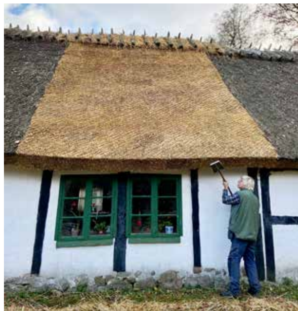
Många "stin" halmtak har lagts på Blåherremölla. Här kontrollerar Ingmar Melin att "skägget" har rätt vinkel. Foto: Camilla Melin
