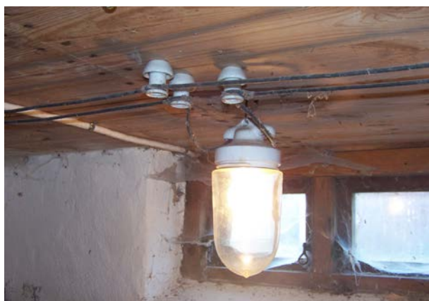
Eldragningar i Sjöflacka skola i Emmislövs socken, som det såg ut på 1920- och 1930-talen. Foto: Sven Jensén 2008
