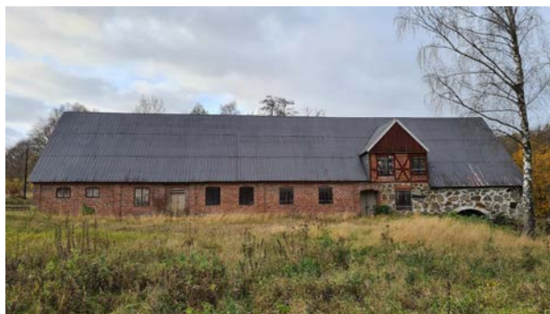
Möllan ingår som del i en mycket lång byggnad. Till vänster finner man stallet, i mitten möllarebostaden och till höger själva vattenkvarnen.
