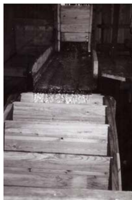
Kvarnen i Skinnemyra är en överfallskvarn, vilket ger den bästa effekten i kvarnens drift jämfört med bröstfalls- och underfallshjul.
