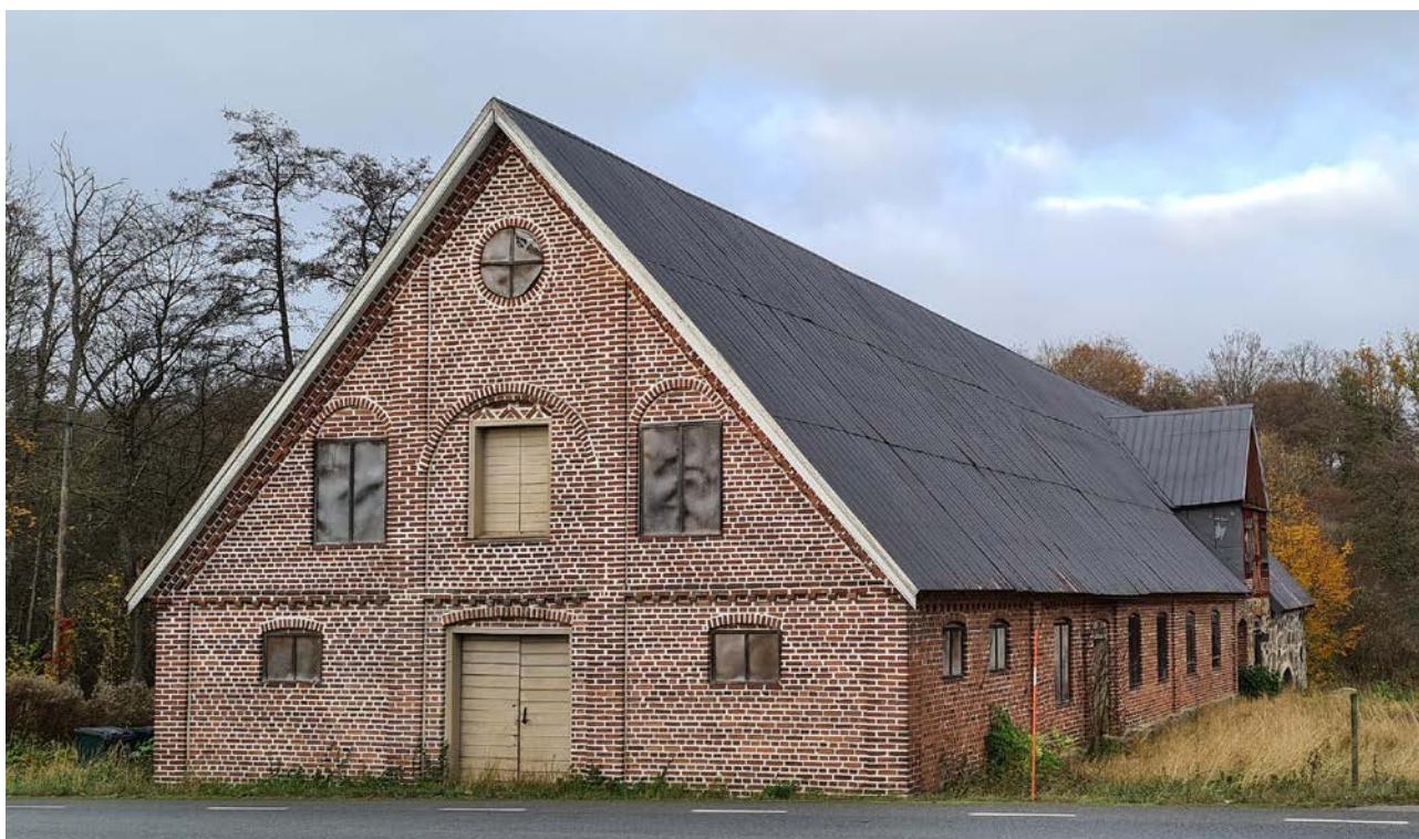
Den vackra tegelväggen från 1860-talet vetter ut mot vägen.
