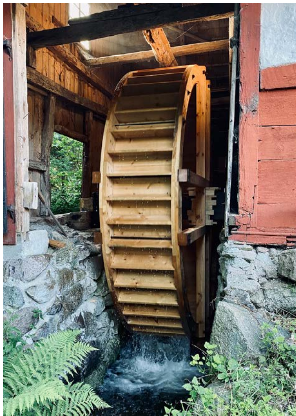
Möllan fick nytt vattenhjul 2021 med en diameter om ca 4,2 meter. Hjulet tillverkades av Gunnar Zackrisson. Foto: Camilla Melin
