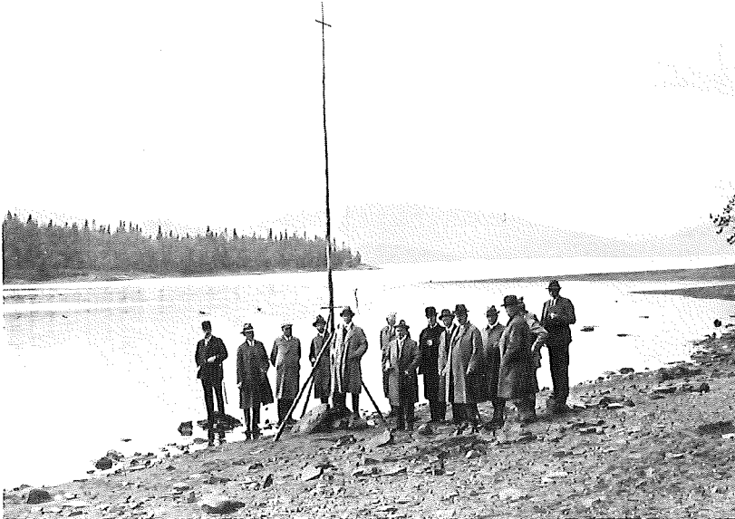
Inför planerade sjöregleringar gjorde regleringsföreningen syn. Här står Indalsälvens regleringsförening på sjön Torröns strand i Kalls socken i västra Jämtland. Torröns yta kom tidvis att höjas till stångens topp. Foto: Jämtlands läns museum.
