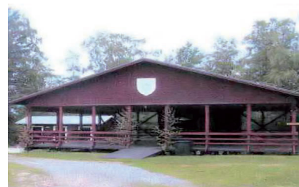
Oisolerade anläggningar dansbana / scenbyggnad med tak mm.
