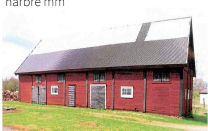
Hus av enklare karaktär, stall, lada, loge, mm
