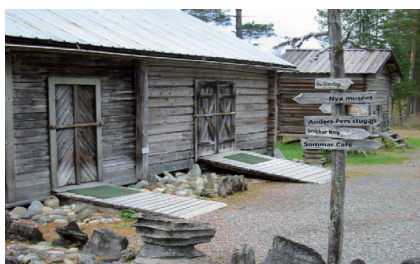
Hus med enkla väggar, lider, förråd
