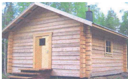
Nybyggd timmerstuga för uthyrning
