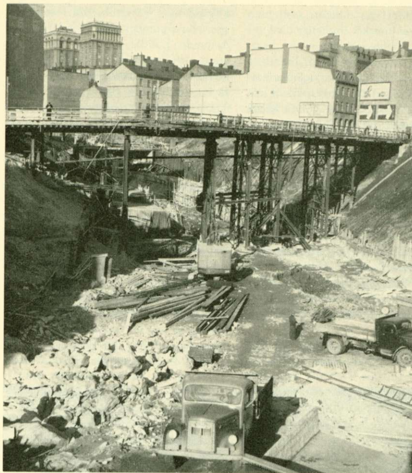
Har grävskeporna fått för stort svängrum vid regleringen av nedre Norrmalm i Stockholm? Är vi i färd med en vandalisering som inte är nödvändig?
