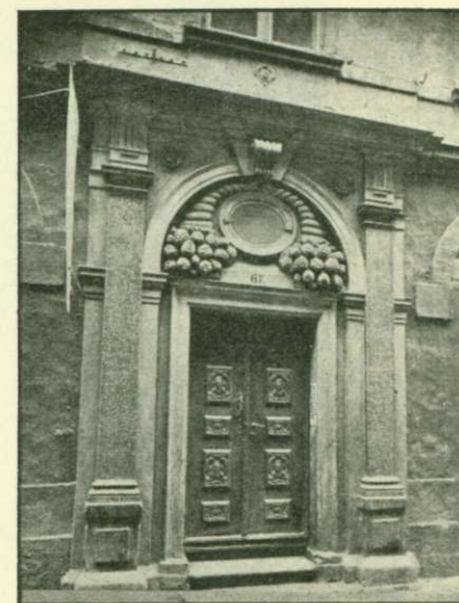
Portal Västerlånggatan 65. (1600-talet.)
