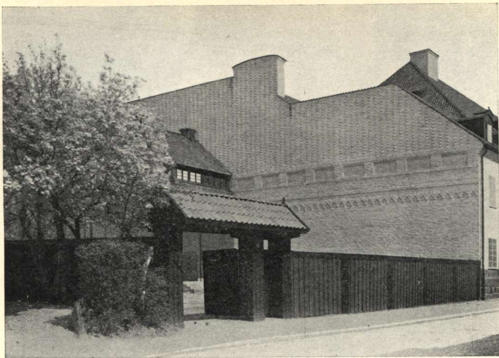
Brandmur och plank.
