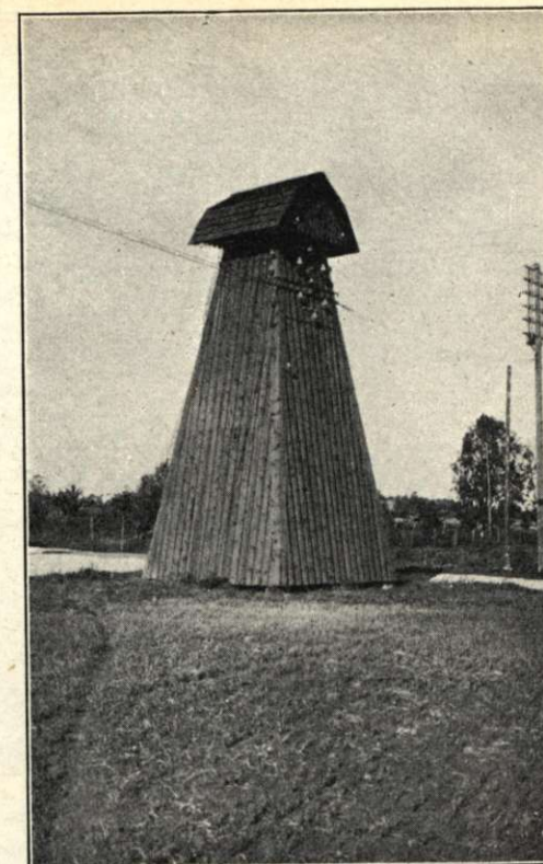
Transformator vid Domnarvet.
