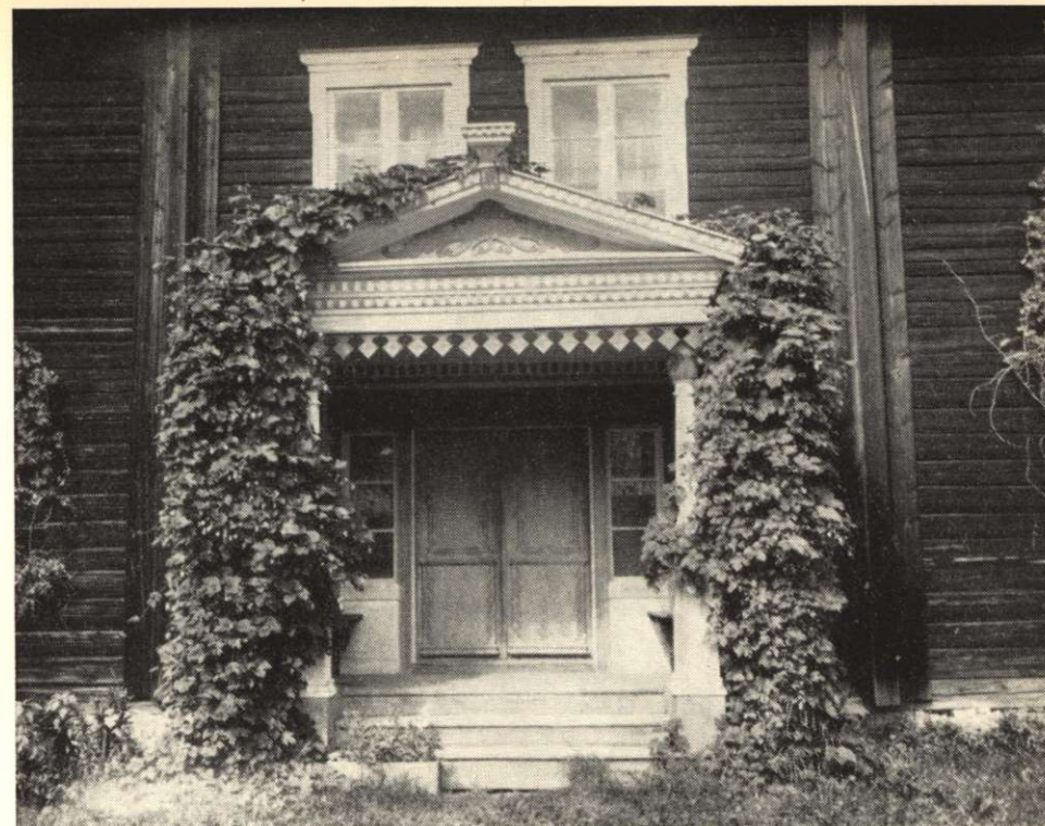
Portalen bör skonas vid en modernisering, antingen den är helt enkel eller som på bilden ovan ett festligt smycke på Hälsinge-gårdens strama timmerbyggnader. Genom att låta fyllningarna i panelverket på ömse sidor om dörrarna bli fönster har man fått in ljus i förstugan.
