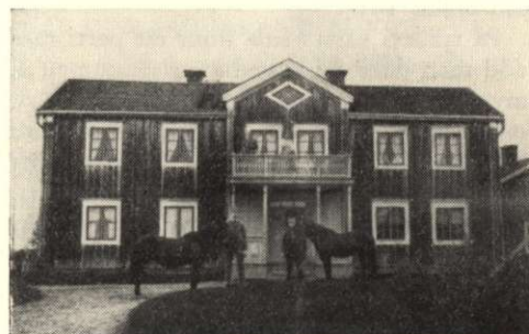
Fig. 1. Verandan före ombyggnaden.
