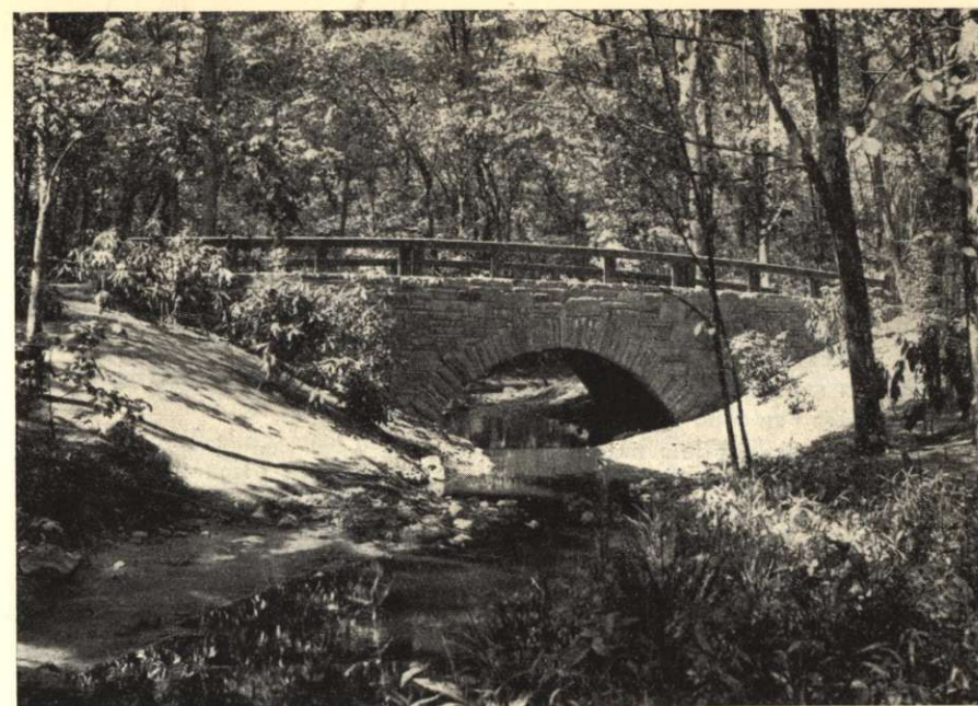
Ny bro av armerad betong med sidorna beklädda med natursten. Genom plantering vid brofästena och mjukt utformade släntor har den väl anslutits till terrängen. Här har man målmedvetet skapat nya skönhetsvärden. Foto: U. S. National Parc Service.
