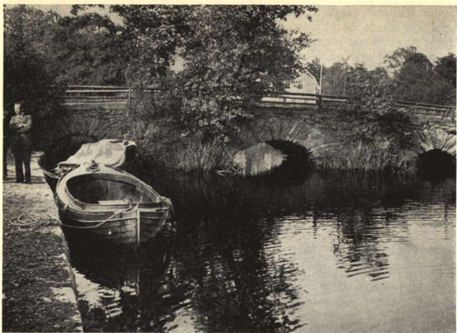
En gammal bro som denna borde väl vara värd att bevaras — och likväl lär den vara dömd att rivas för att den »ligger i vägen» för den nya. Samfundets bildarkiv, foto: Hermelin.
