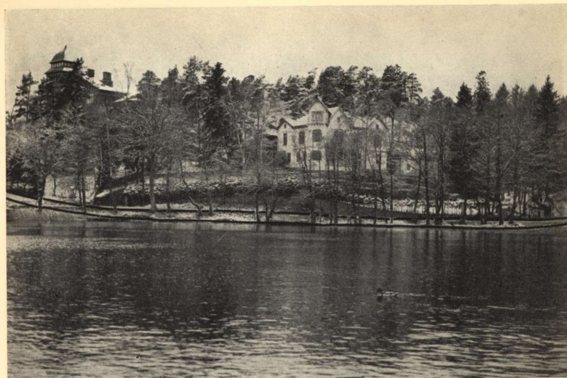
Väg utmed Baggensfjärden vid Saltsjöbaden. — Vid planerad breddning och rätning av denna idylliska väg har man tänkt operera bort en stor del av strandvegetationen.
