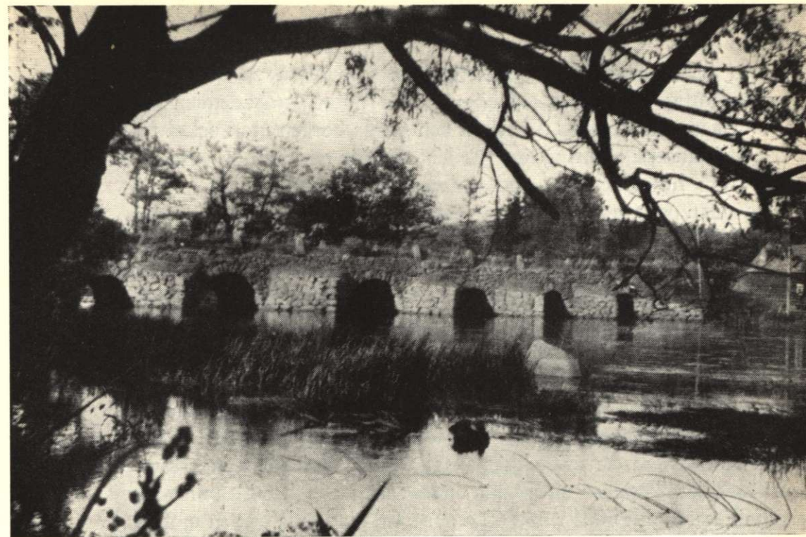
Öjebron, Östergötland, som blivit överflödig genom vägomläggning och skulle ha rivits. Nu har den räddats åt eftervärlden som en parallell och samtidigt en motsats till den nyuppförda bron, belägen ett femtiotal meter längre bort.
