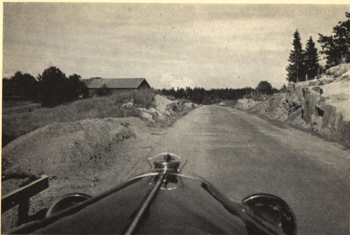
En rundad bergsnalle har genomskurits av vägen. Man kan här mildra det brutala ingreppet i naturen genom att spränga av de största knaggarna och dölja de fula sprängytorna till höger med lämplig vegetation och helt och hållet borttaga den kvarlämnade klacken till vänster. Foto: Sven A. Hermelin.
