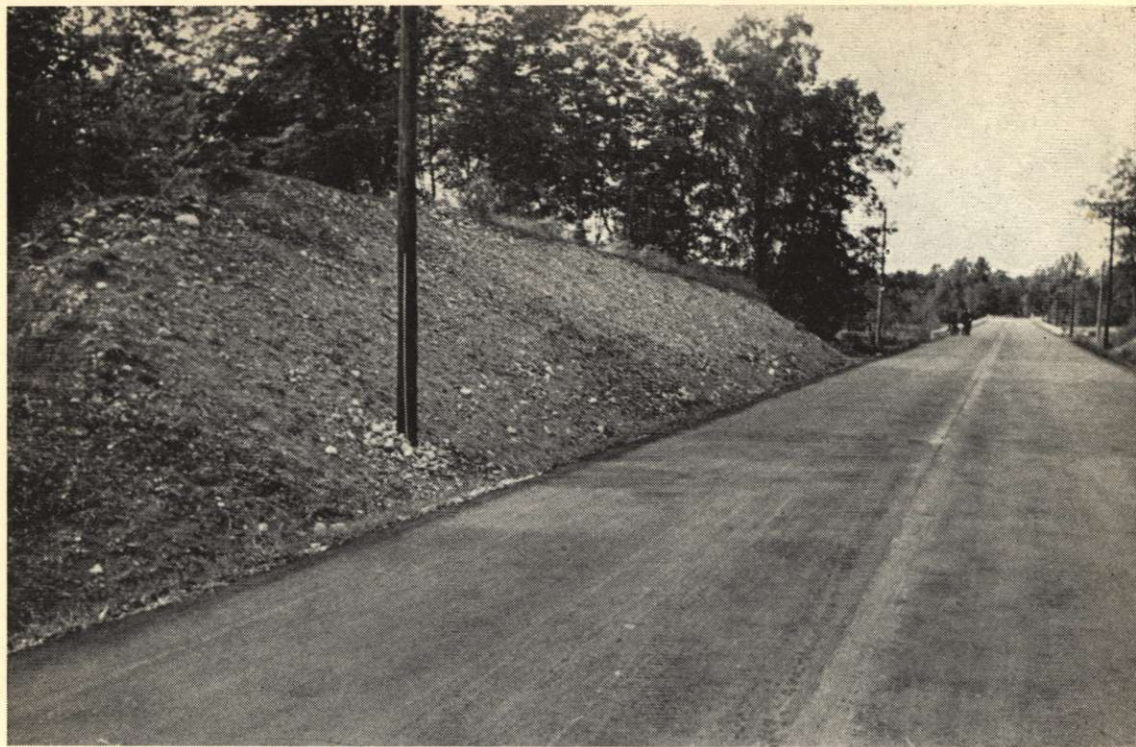
Nyanlagd väg, där slänten ännu ej blivit iordningställd. Den kala grusbacken bör mjukas upp och förses med lämplig vegetation. Södra Sverige. Foto: Samfundet för Hembygdsvård.
