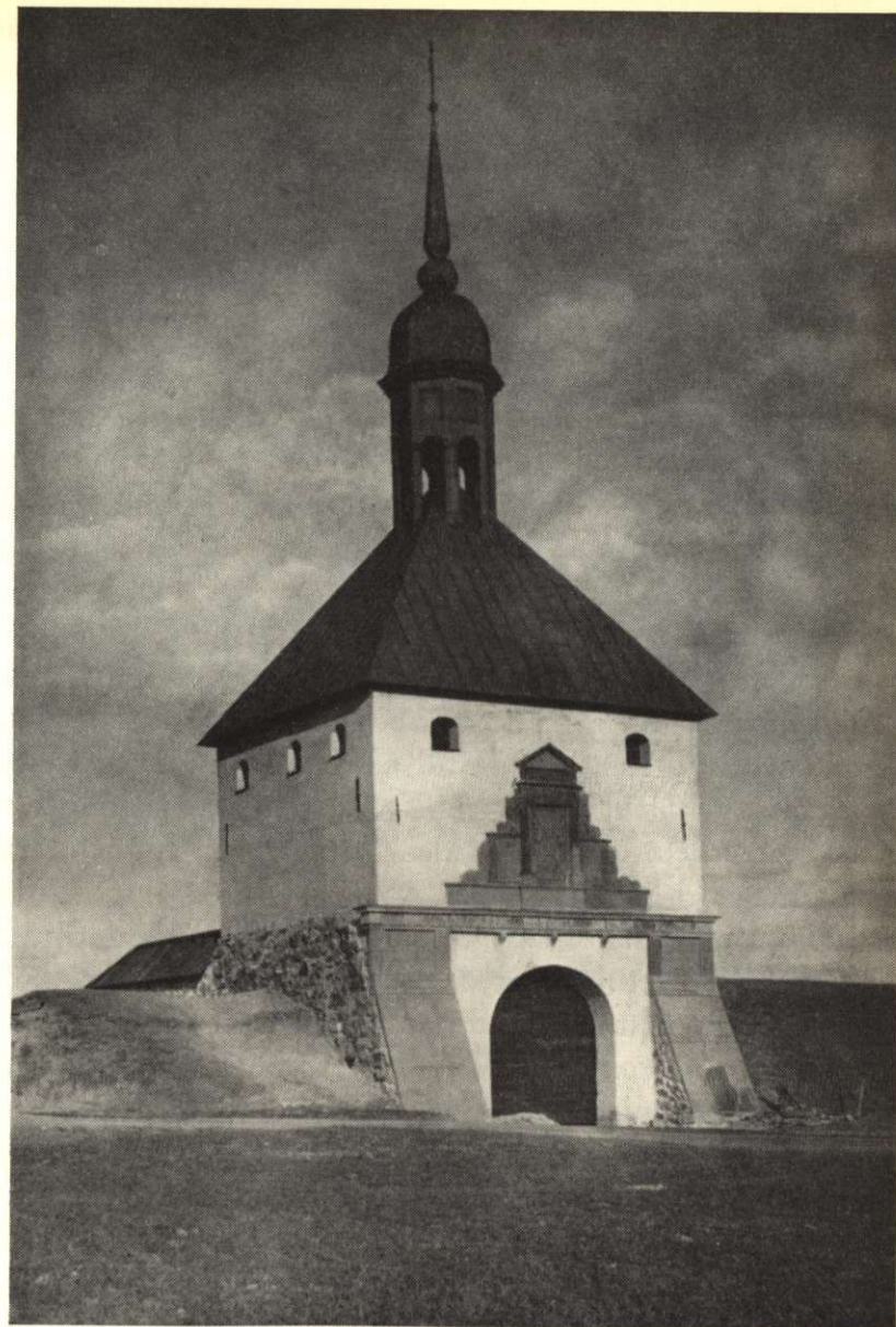
Johannisborg vid Norrköping. Den statliga befästningsanläggningens porttorn har iståndsatts så fullständigt, att byggnaden återfått den ursprungliga formen.
