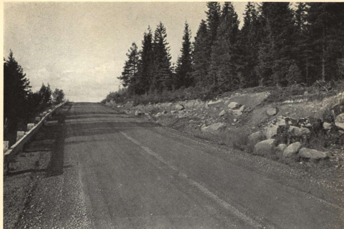
Övergången mellan vägen och skogen brytes brutalt av skräpande stenblock och fula schaktsår. Det dröjer många år innan naturen själv kan läka dessa. Västra Sverige. Foto: Samfundet för Hembygdsvård.
