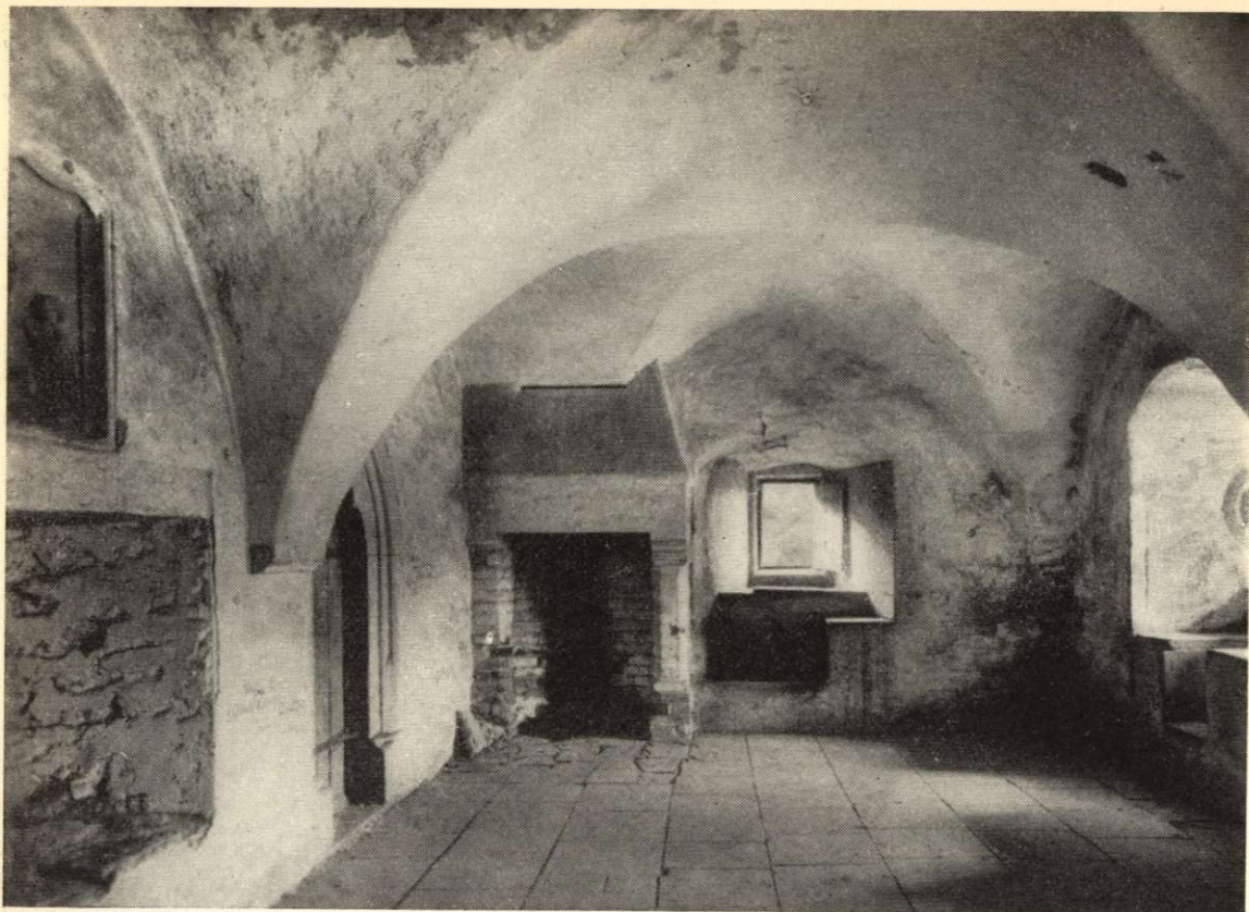
Dagligstugan, huvudrummet i borgherrskapets egentliga bostad, med öppen spis och mindre bänkar i de djupa fönsternischerna.
