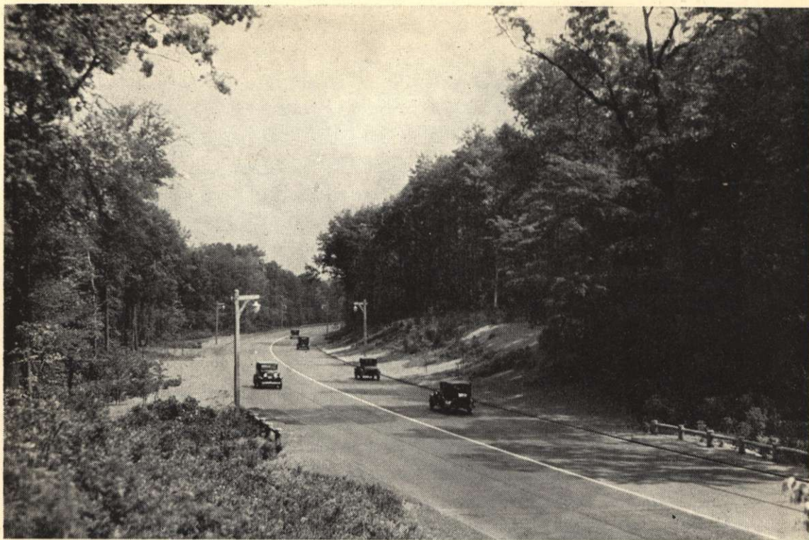
De amerikanska vägar, som föra ut till fritidsområdena, äro goda exempel på den kultiverade vägen. Vägslänterna äro planterade med inhemskt växtmaterial, som kräver ett minimum av underhåll. Northern State Parkway, N. Y.
