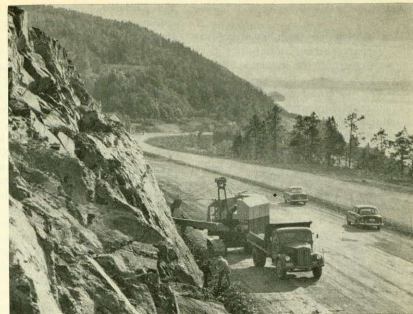
Motorvägen längs Vättern nära Huskvarna under byggnad.
