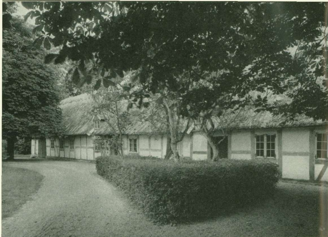
Den östra flygeln restaurerades 1928 efter ritningar av professor Erik Lundberg och inreddes då till församlingshem.
