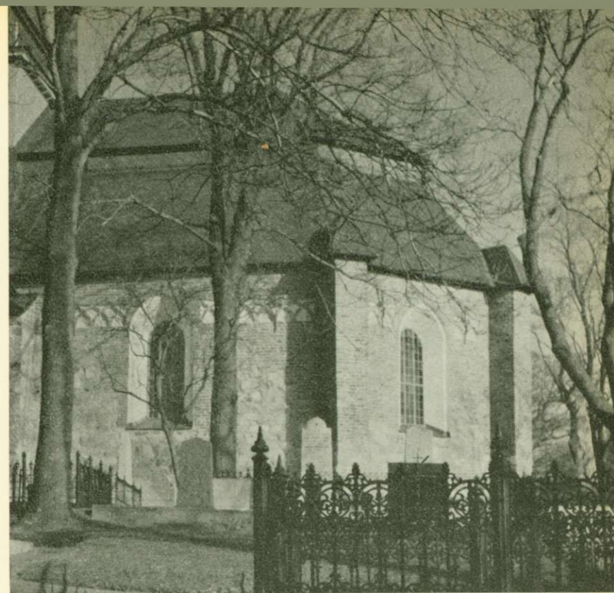
Enköpings Vårfrukyrka. Murhålen sitter tätt under taklisten. Deras proportioner bli inte harmoniska förr än man ser murhålen emot både vägg och tak såsom ett enda sammanhängande rummets "skal".
