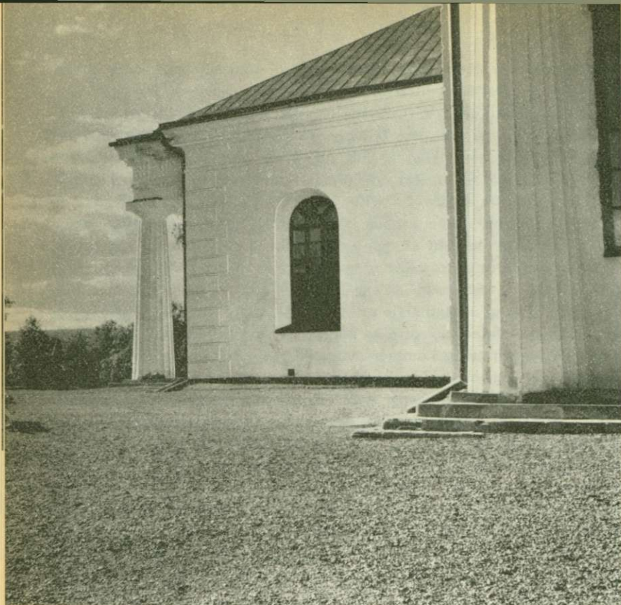
Skellefteå landskyrka. Fönsterplacering i klassicistisk arkitektur. Fönsterhålet är placerat så att muren sluter likvärdigt omkring på alla sidor. Gesimsens listverk kröner och lyfter i väggens helhet. Taket bildar en "pyramid" ovan listen.
