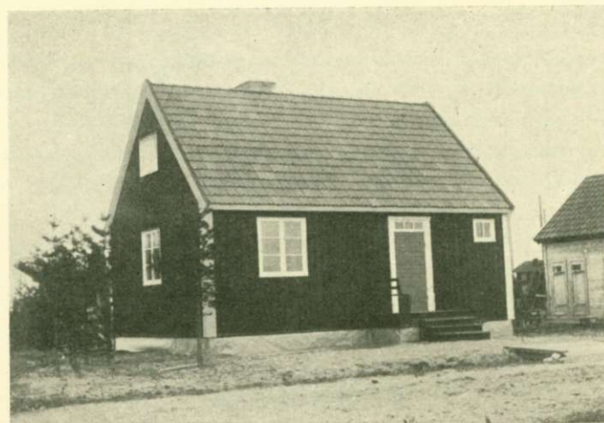
Fig. 2. "Standardstuga" färdigpanelad och målad på åtta dagar.
