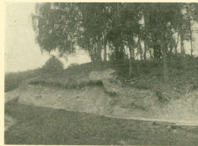
Dyrehögen vid Järpås kyrka (Östergötland). Har delvis skadats och sedan måst borttagas för att tillfredsställa en cementfabriks behov av sand.
