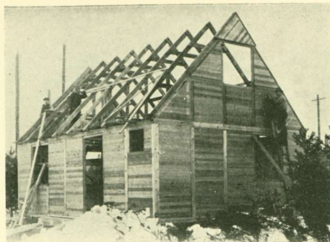
Fig. 1. Stomme till fabrikmässigt tillverkad stuga. Vägdelarna synas tydligt.
