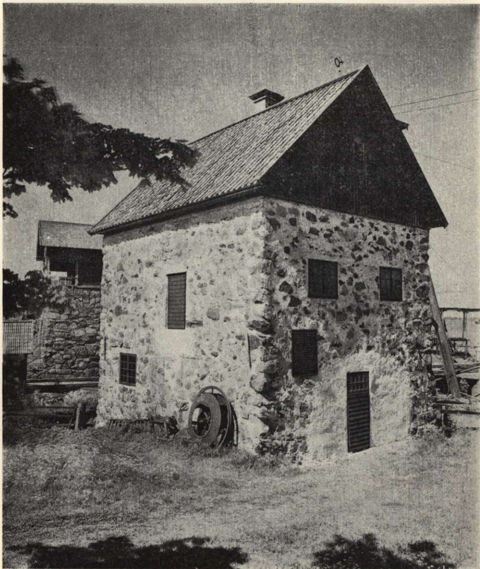
Fig. 5. Ångmaskinshus från 1728 vid Dannemora gruvor.
