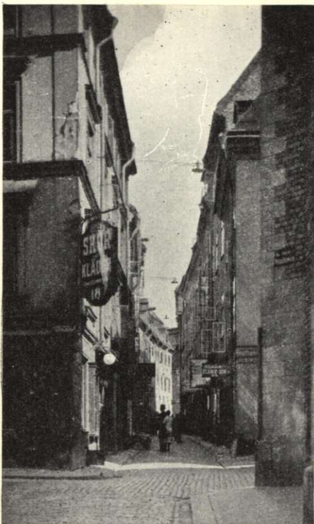
Kinstugatan sedd från hörnet av Svartmangatan.
