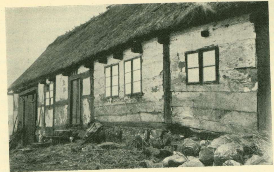
Boningslänga i blandad teknik av korsvirke och skiftesverk (»bålestua»), Kropps s:n. Foto författaren.
