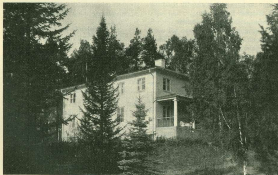
Tjänstemannabostad, tillhörig St. Kopparbergs Bergslags A.-B., Falun. Premierad av Samfundet för hembygdsvård 1927.
