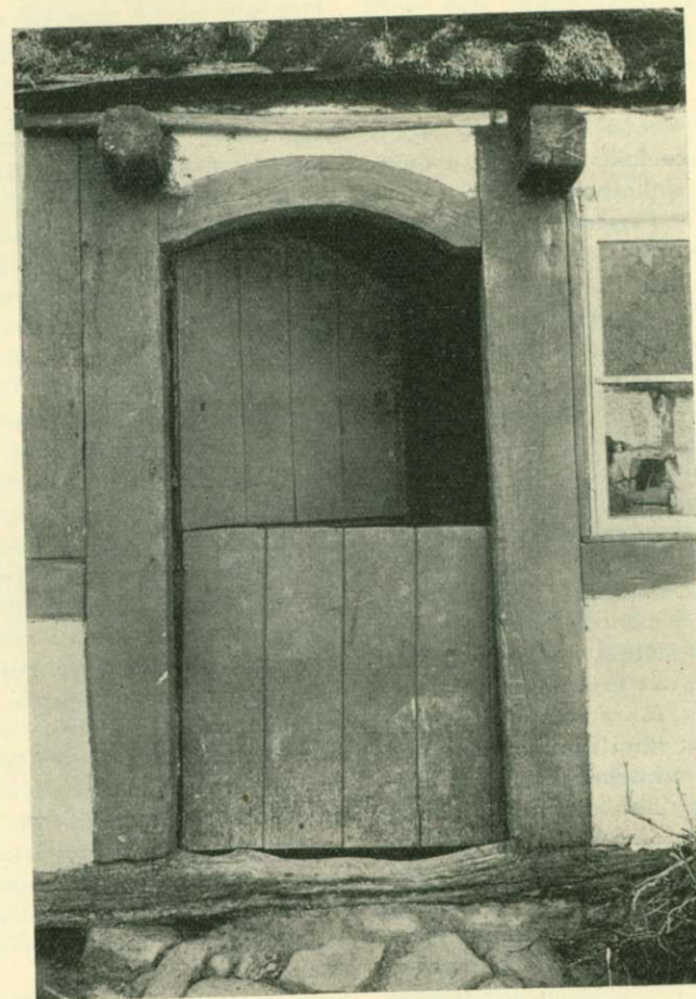
Ingångsdörr till gården Ornakärr, Väsby s:n. (Obs. det grova timret av kärnek). Foto författaren.
