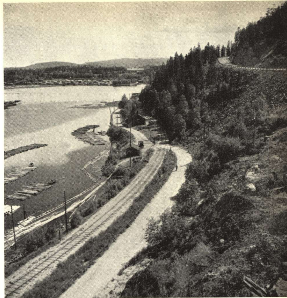
Järnväg och landsväg följa älven. Den nya vägen ger genom sitt höga läge en vacker utsikt och undviker den farliga korsningen med järnvägen. — Kramfors.
