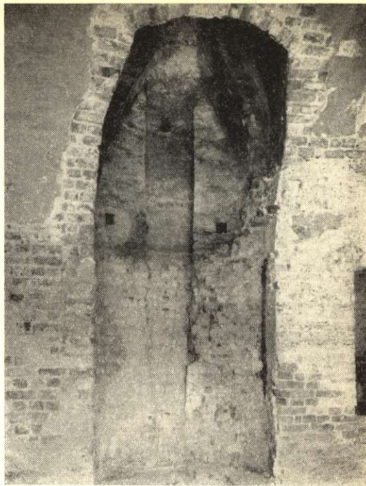
Fig. 12. Hörnspisel på Malmöhus. — Fig. 13. Bild av spisel på Malmöhus, tagen före rekonstruktionen av huven. Man ser här hur urtagningen i ryggen är anordnad.
