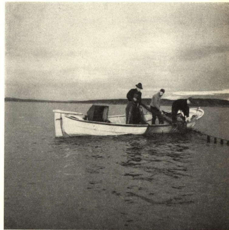
Storryssjor äro fångstredskap, vars storlek kan variera högst betydligt. Mynningsgarnet kan vara från 3 till 12 meter djupt, sido- eller krokarmarna kunna vara från 12 till 30 meter och landarmens längd kan variera mellan 50 och 180 meter. Dessa redskap härstamma från Finland. De användas för fångst av större fisk, i huvudsak sik, lax och öring. — Storryssjan sättes på tork. Allsta, Nora.
