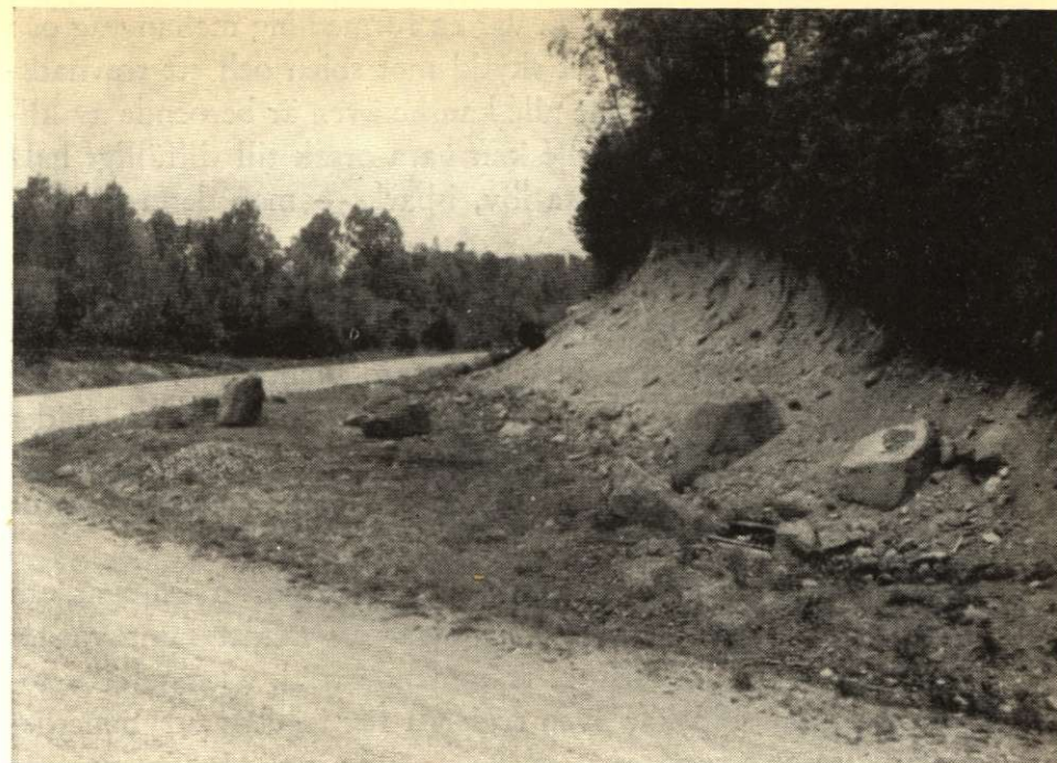
Vägarbetet avslutat. Skall det i skärningen uppkomna såret läkas? (Sverige.)
