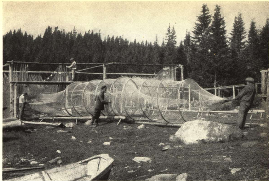
Storryssjor äro fångstredskap, vars storlek kan variera högst betydligt. Mynningsgarnet kan vara från 3 till 12 meter djupt, sido- eller krokarmarna kunna vara från 12 till 30 meter och landarmens längd kan variera mellan 50 och 180 meter. Dessa redskap härstamma från Finland. De användas för fångst av större fisk, i huvudsak sik, lax och öring. — Storryssjan sättes på tork. Allsta, Nora.
