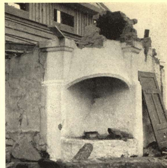
Fig. 28. Spisel med uppsvängd kupa. — Fig. 29. Hörnspisel med uppsvängd kupa; från bondstuga i Värmland.
